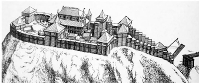
Рис. 4. Реконструкція замку 70–80-ї рр. XX ст. (История СССР 1983, с. 66)
