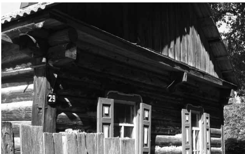
Ил. 10. Випуски колод верхніх вінців для підтримки конструкції даху. сmt Любеч Ріпкинського р-ну. Світлина А. Ярової. 2016 р.
