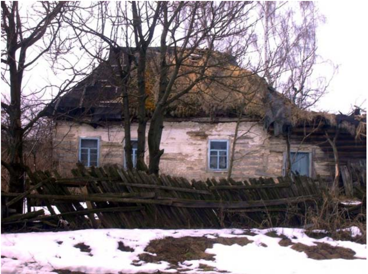
Рис. 35. Дах з покриття стріхи «в натруску», с. Роїще, Ріпкинський район. Фото О. Бондаря, 2006 р.
