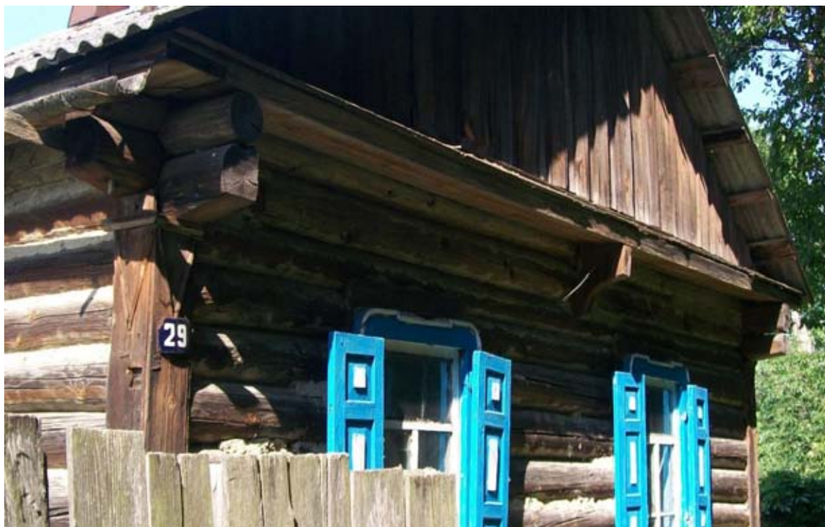
Рис. 24 Випуски колод верхніх вінців для підтримки конструкції даху. Смт. Любеч, Ріпкинський район. Фото А. Ярової, 2016 р.
