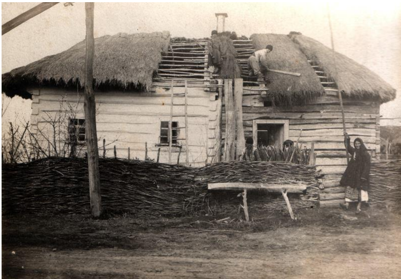
Рис. 25 Покриття даху («снопками»), 1906 – 1907 рр. С. Грабівка, Куликівський район.
