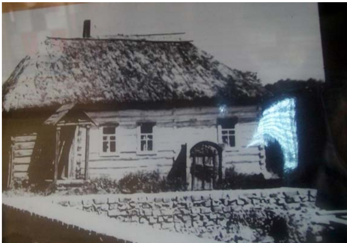
Рис. 27. Дах з півзинами. Фото з експозиції Мезинського НПП
