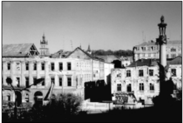
Будинки №№ 9, 10 у процесі руйнування. Фото М.Бевза 17.01.1998
