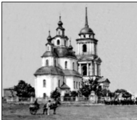
Загальний вигляд церкви з дзвіницею. Фото початку XX ст.
