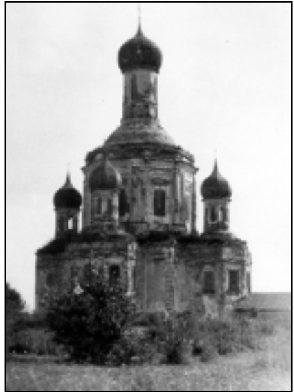
Загальний вигляд церкви. Фото 1950-х років
