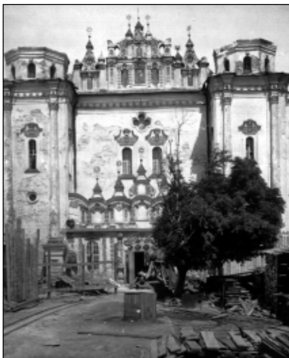
Західний фасад собору під час руйнування 1934 р.
