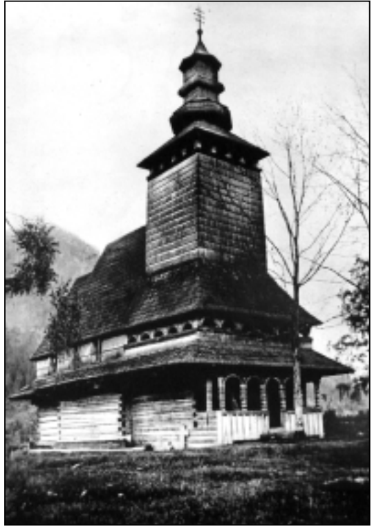
Загальний вигляд церкви. Фото Б.Вавроушека 1929 р.
