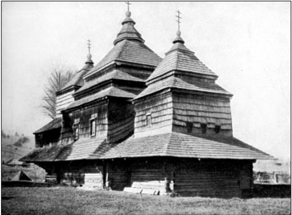
Загальний вигляд церкви. Фото О.Маркова початку XX ст.
