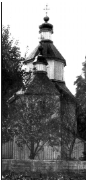
Східний фасад церкви. Фото С.Таранушенка початку 1930-х років
