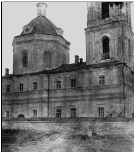
Фрагмент північного фасаду церкви. Фото С.Таранушенка 1914 р
