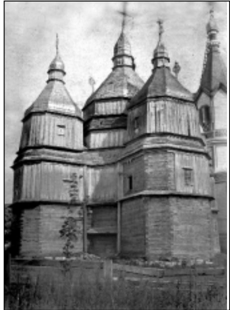
Церква під час ремонту. Фото початку ХХ ст.
