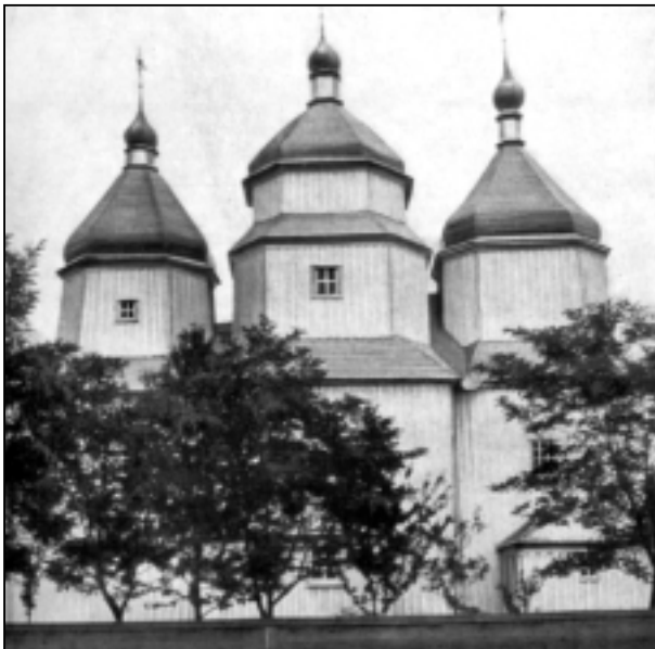
Південний фасад церкви. Фото початку ХХ ст. За Г.Логвином
