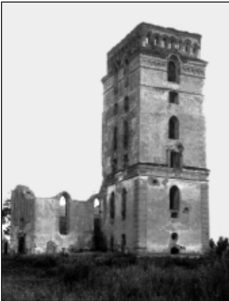
Загальний вигляд руйн. Фото Камінського 1963 р.
