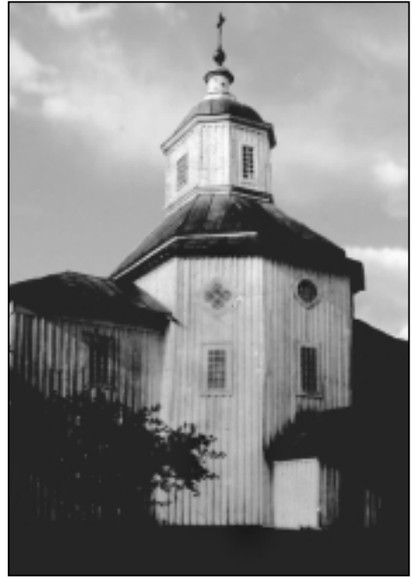
Загальний вигляд церкви. Фото 1920-х років
