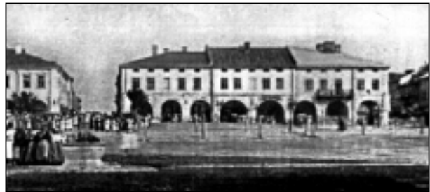
Загальний вигляд будинків. Фото початку XX ст.
