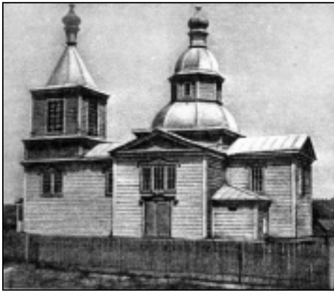
Загальний вигляд церкви. Фото 1970-х років
