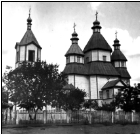
Загальний вигляд Введенської церкви з дзвіницею. Фото Г.Павлуцького кінця ХІХ ст.
