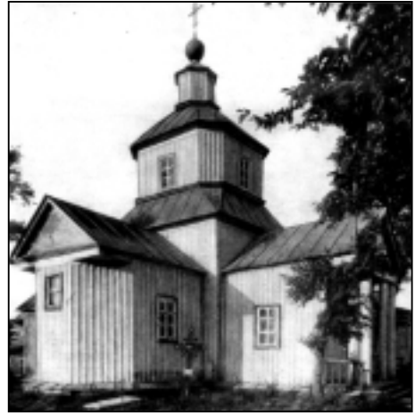
Загальний вигляд церкви зі сходу. Фото С.Таранушенка 1914 р.
