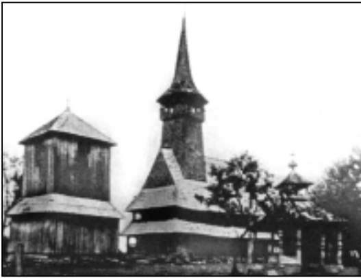
Загальний вигляд церкви та дзвіниці.
