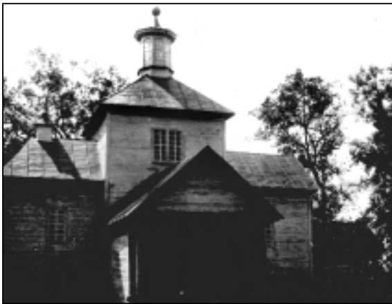
Загальний вигляд церкви. Фото 1930-х років
