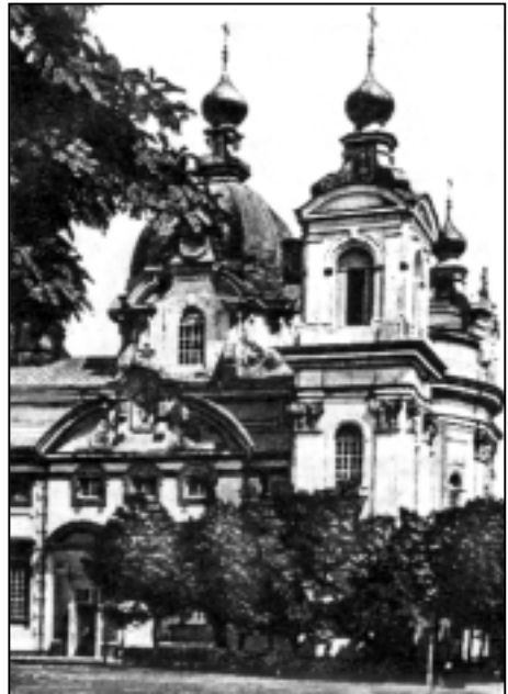
Загальний вигляд костелу за фото початку ХХ ст.
