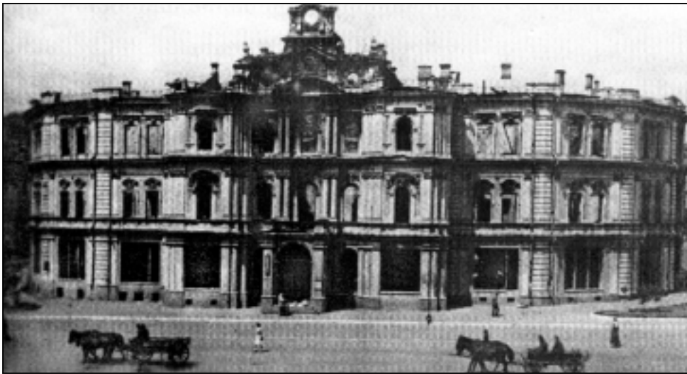
Фасад будинку після пожежі 1941 р.
