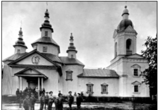
Північний фасад церкви.
