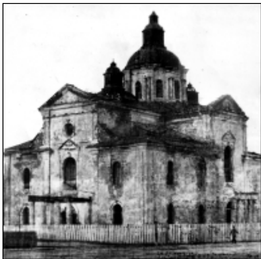
Загальний вигляд собору. Фото Н.Новаковської 1952 р.
