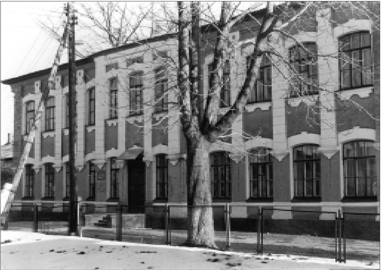
1999 рік. Приміщення сучасної ЗОШ №5, що на вул. І.Гончара (колишній Колейовій, Юзефа Пілсудського, Адольфа Гітлера та 17 Вересня).
