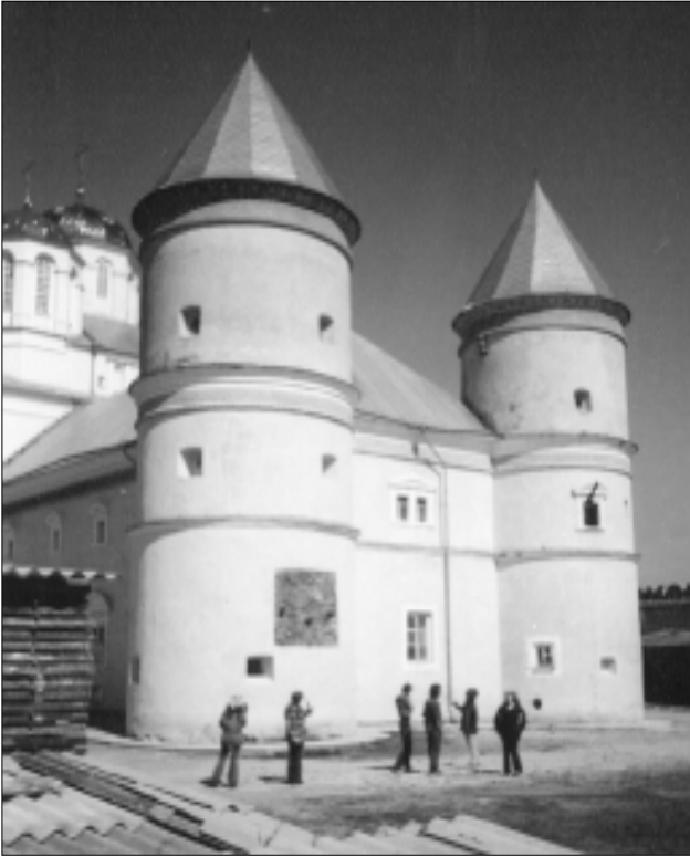
Мури Межиріцького замку поблизу Острога. Фото 2003 року.
