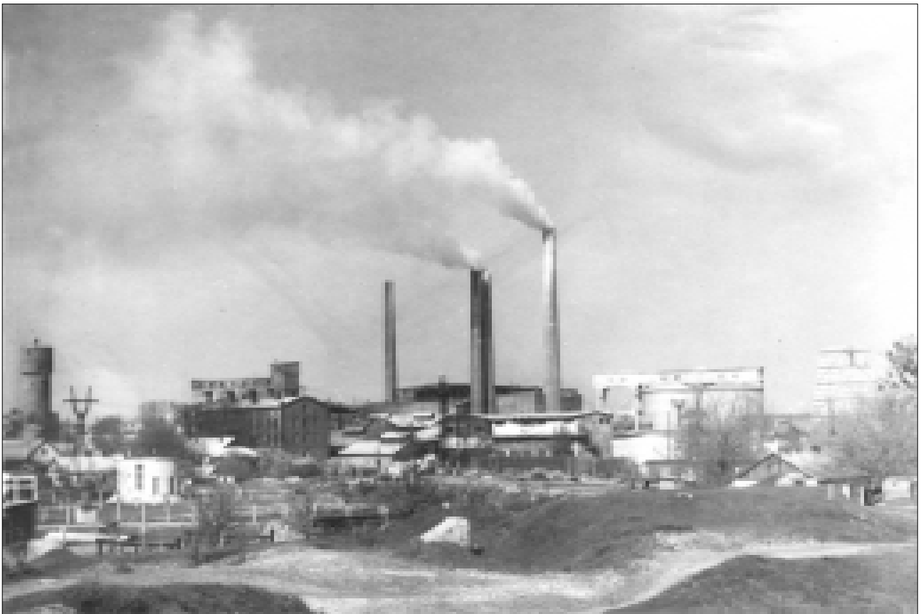
1980 рік. Загальний вигляд корпусів старого цементного заводу від «140-го кілометра» залізниці.
