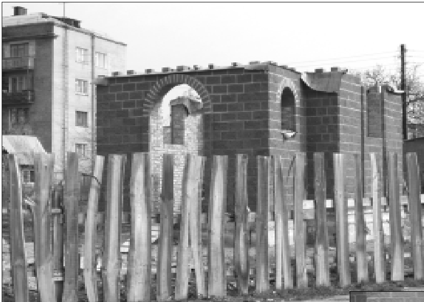
2005 рік. Будівництво греко-католицької каплиці Св. Петра і Павла.
