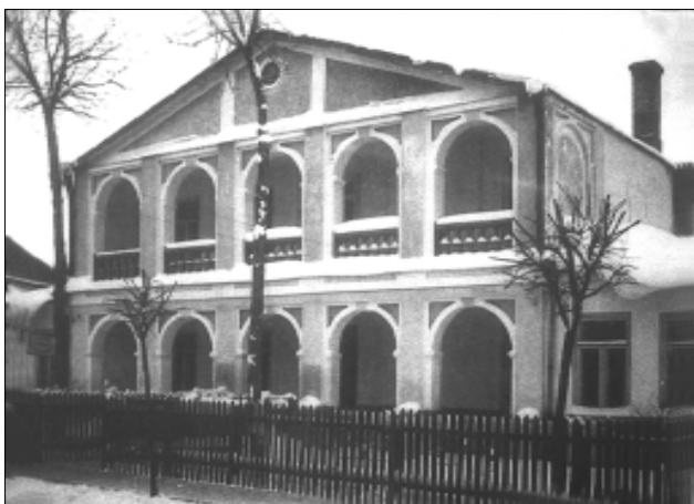
1939 рік. Єврейська синагога на вул. Єрусалимській (нині – вул. П. Чубинського). Приміщення не збереглося.
