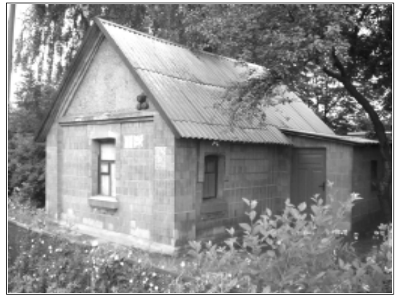
2005 рік. Будинок родини М. Приходька по вул. 8 Березня. Нині – музей-квартира його імені.
