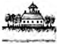
Домъ у працягъ Богдановской Сигнальной станціи
