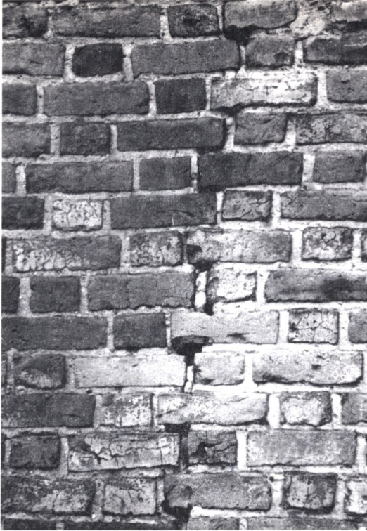
Незаповнені куточки швів замкового муру вказують на послідовність етапів його спорудження (18,20)
