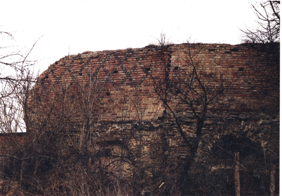
Серед особливостей мурування Окольного замку дослідники відмічають наскрізні фундаментні арки та орнаментальну кладку окремих ділянок стін (21)
