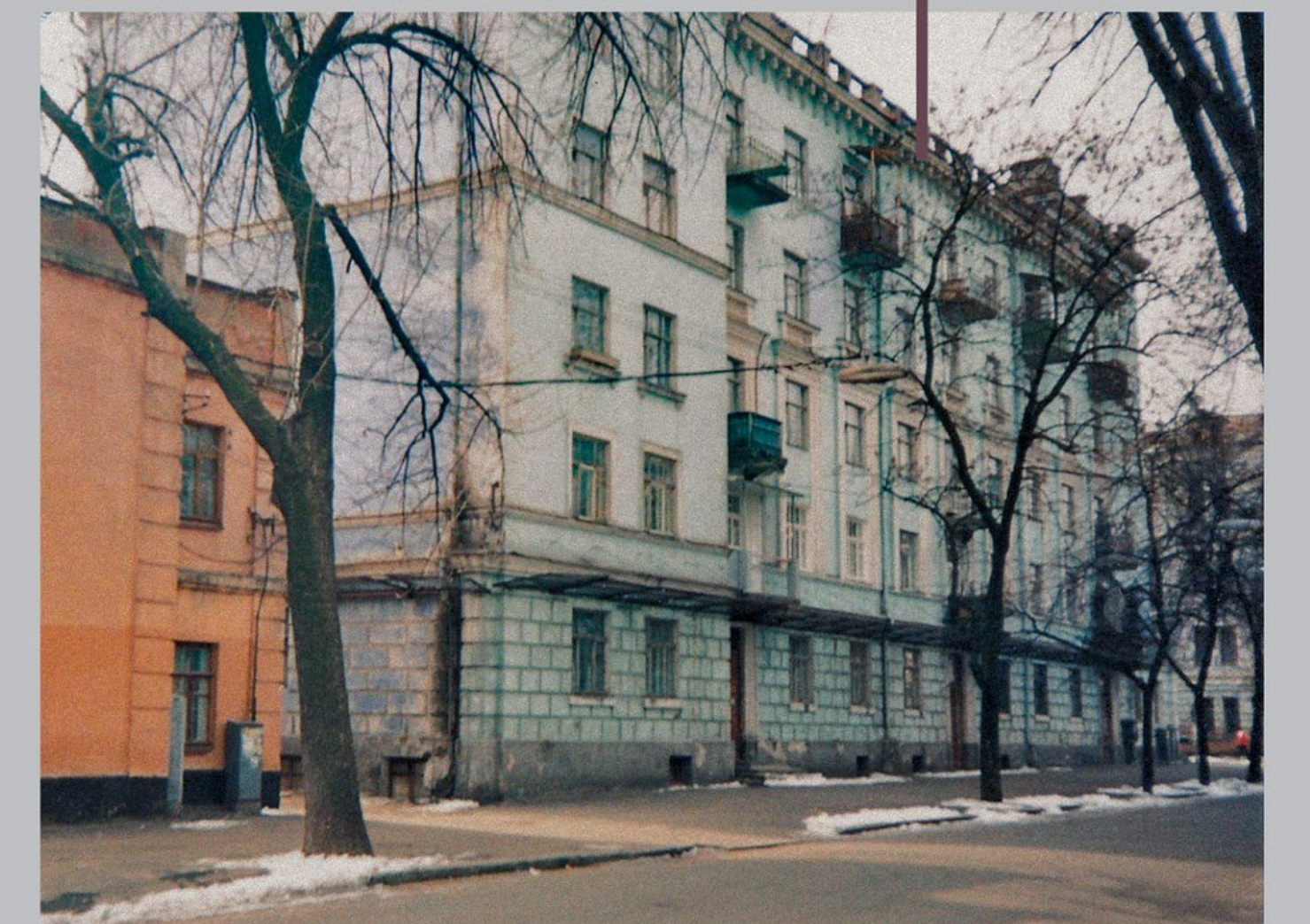
Будинок, який спорудили у 1930-х р. на місці церкви Різдва Предтечі
