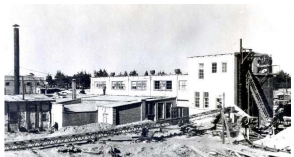
Завод залізобетонних виробів, 1949 рік
