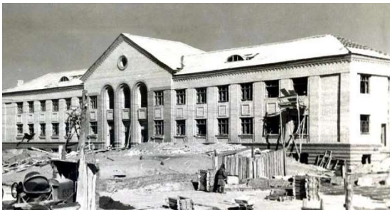
Будується будівля ФЗН 43( ПТУ-24), 1949 рік
