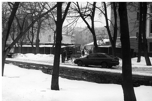
Рис. 31. Будівельний майданчик — місцерозташування розкопу 1 і траншеї 2. На передньому плані — північно-східний кут Петровського парку.
