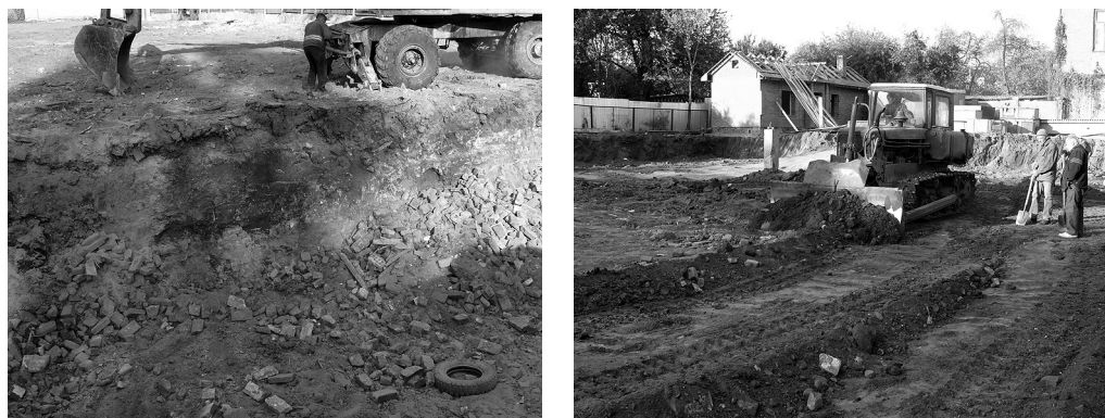
Рис. 3–4. Вибирання котловану погребу будинку за № 22. Профілі ям 2 і 3, перетнутих будівлею ХІХ ст. Зачистка дна котловану. Із заходу та південного заходу.
