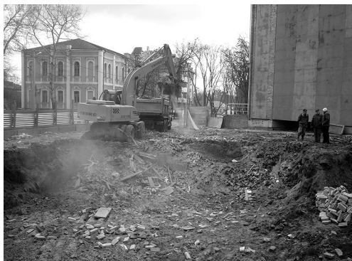
Рис. 55. Початок вибирання котловану. Зі сходу — південного сходу.
