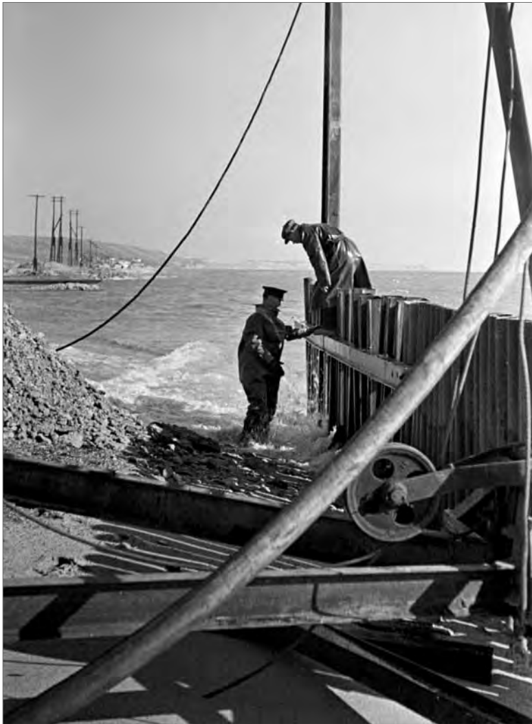
■ Укріплення берегів вхідного каналу шпунтом
