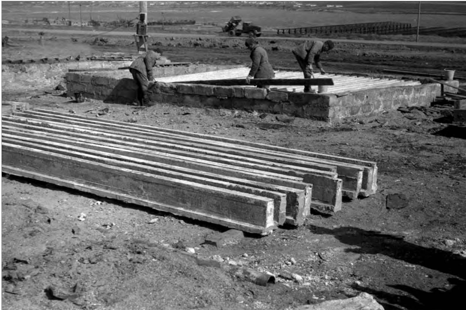
■ Виготовлення залізобетонних несучих балок (весна 1954 р.)
