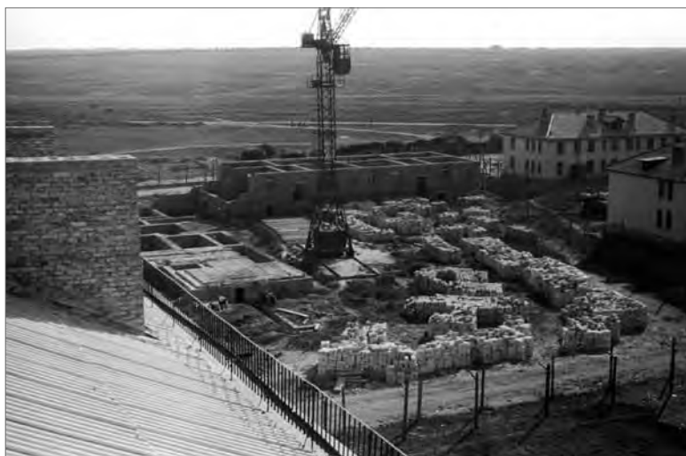
■ Зведення «Червоної будівлі» на розі вулиць Леніна та Миру (літо 1954 року)
