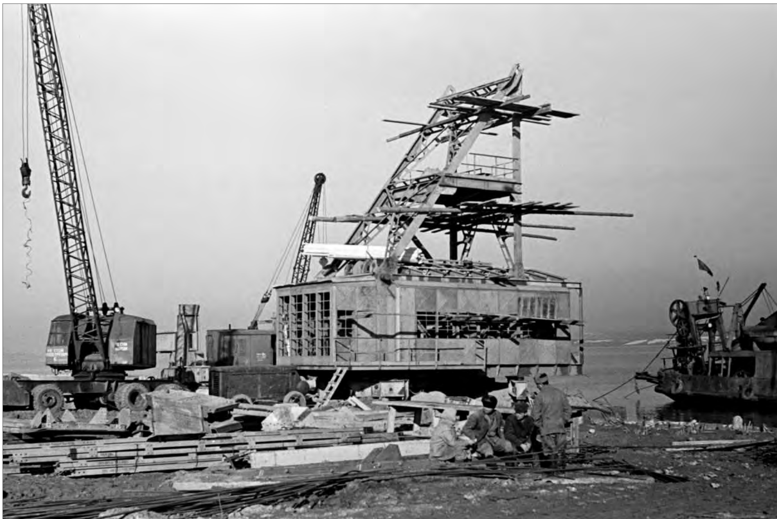
■ Монтаж першого порталного крану фірми «Черетті-Танфані»
