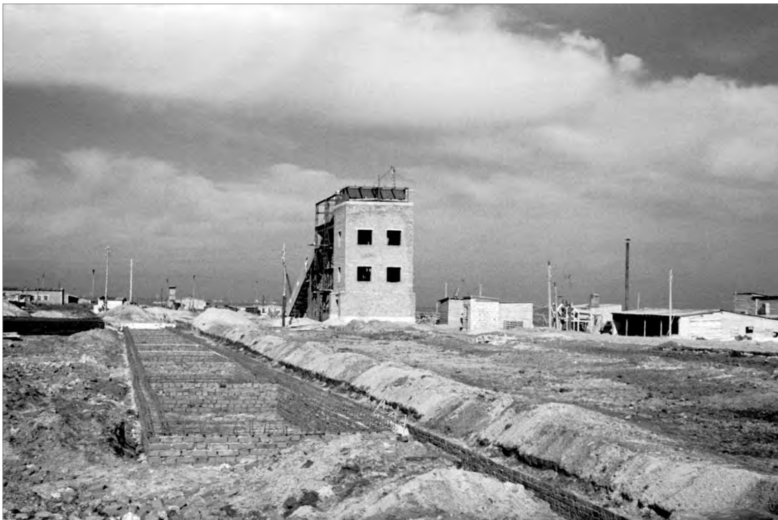
■ Будівництво заводу залізобетонних виробів (1956 р.)
