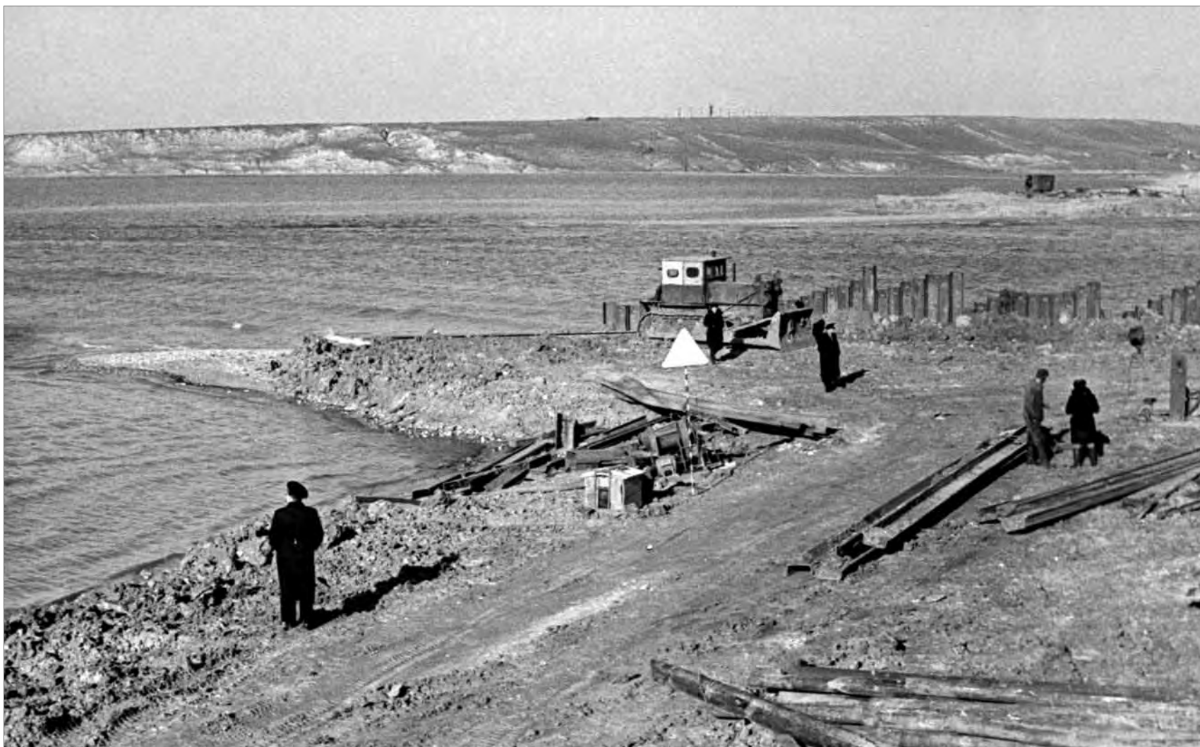
■ Роботи на вхідному каналі
