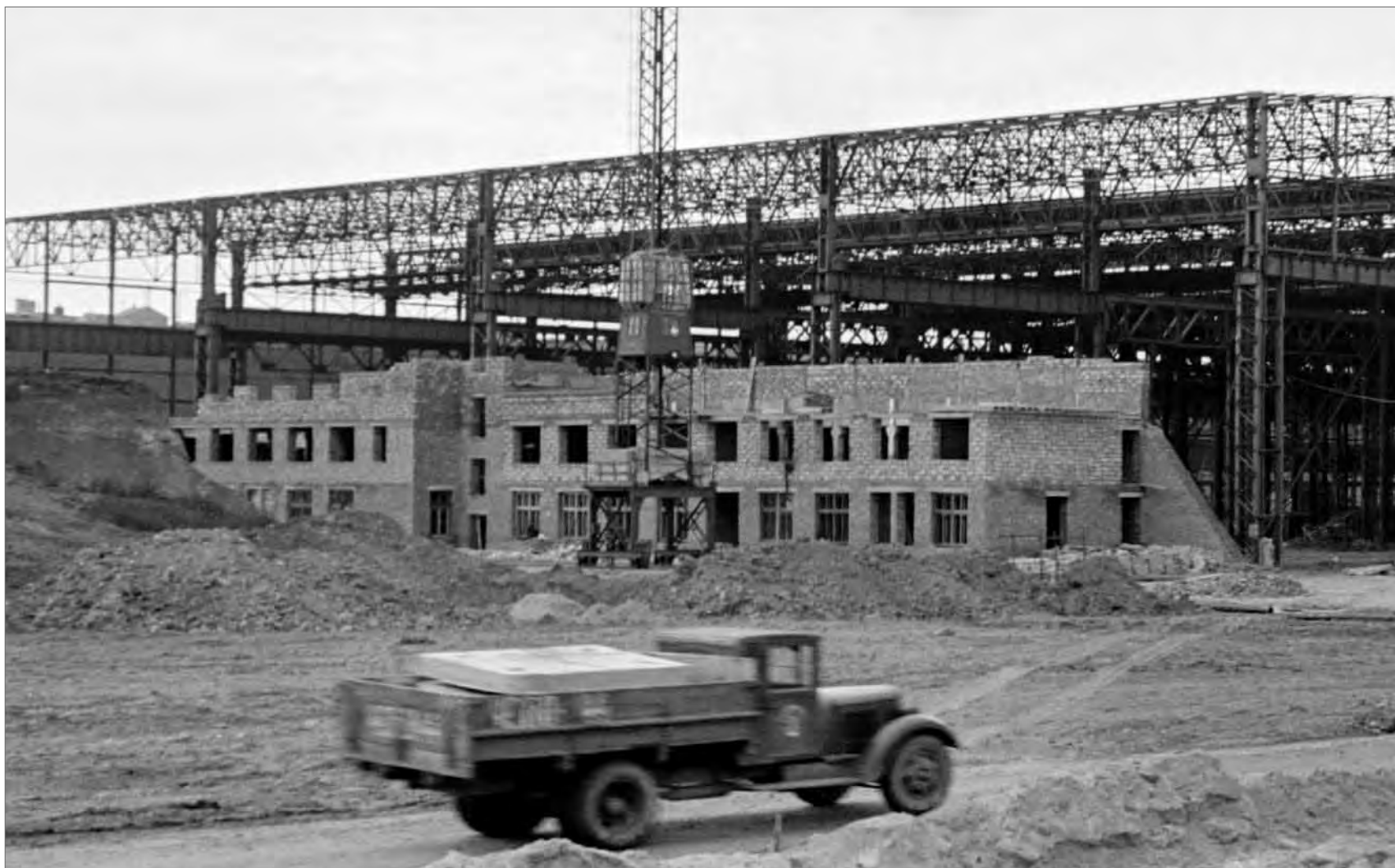
■ На будівництві БКЦ
