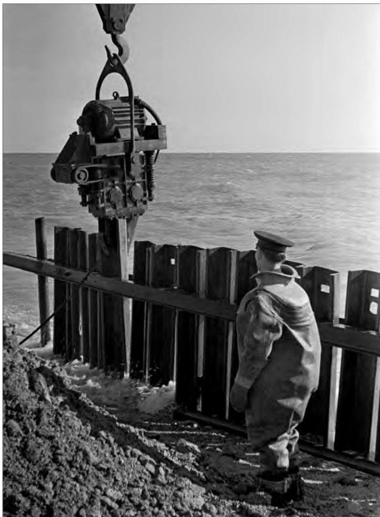
■ Забивання шпунту, палі та труб
