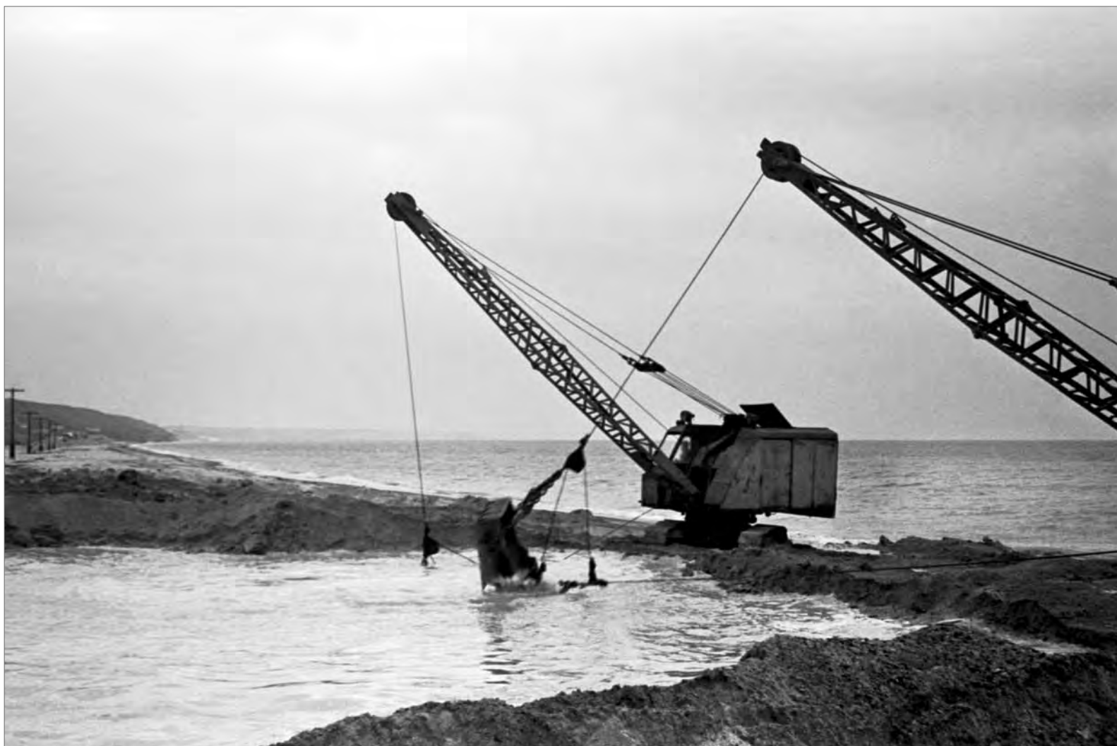
■ Прориття піщаного пересипу екскаваторами (весна 1957 року)
