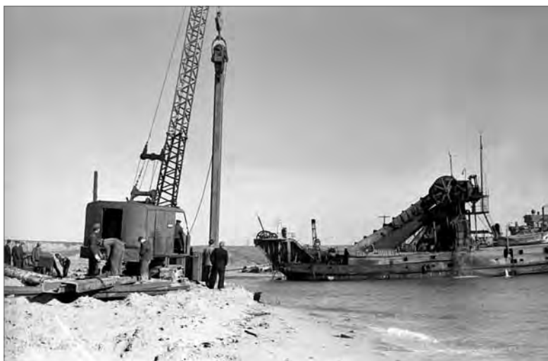
■ Прориття піщаного пересипу земснарядом «Вайгач»
