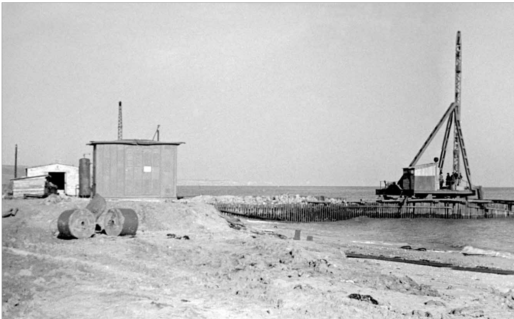
■ Будівництво південної шпори
