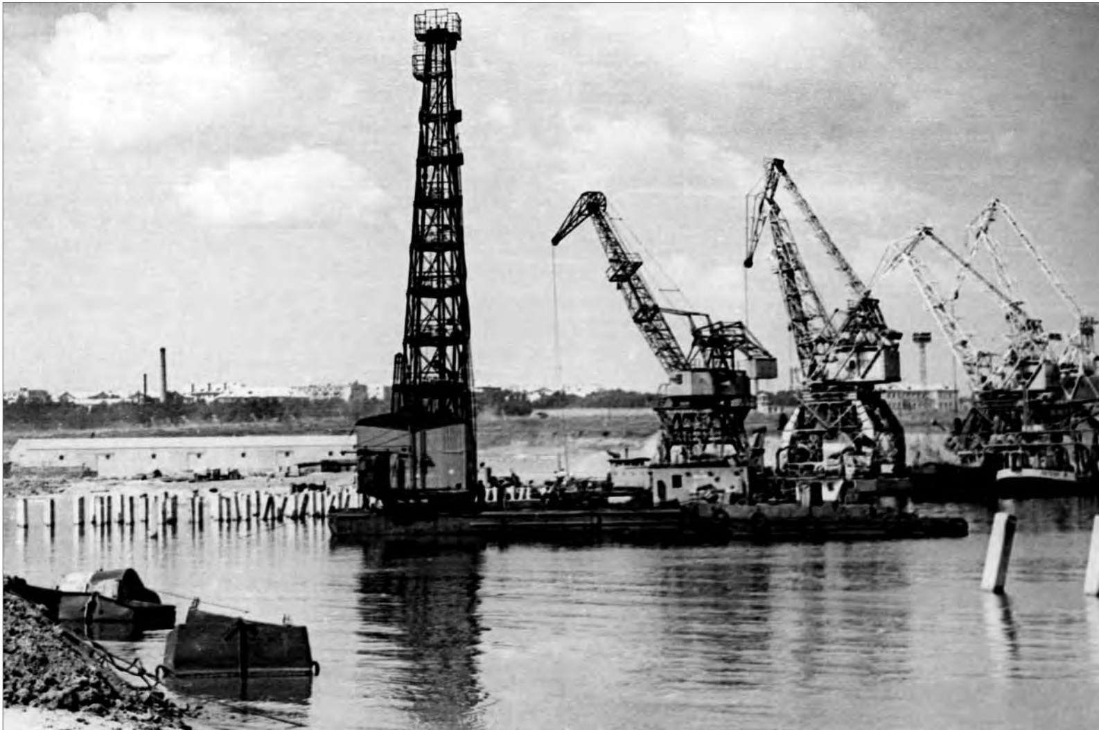
■ Будівництво нових причалів (1961 р.)
