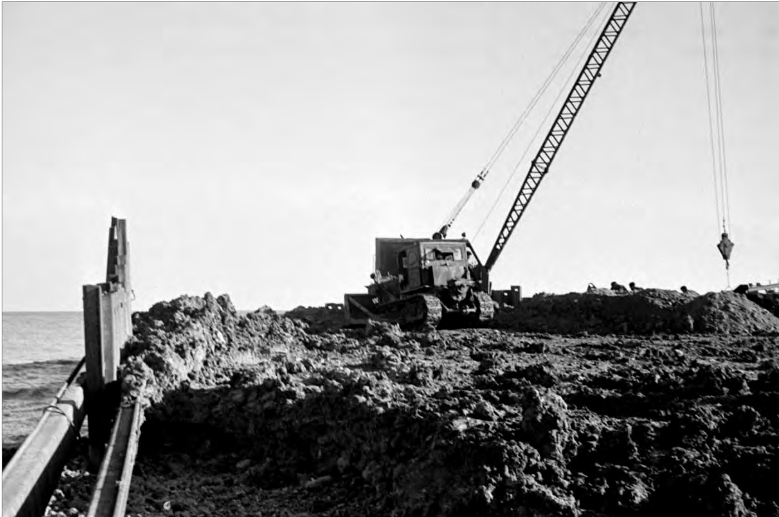
■ Продовження робіт з укріплення вхідного каналу
