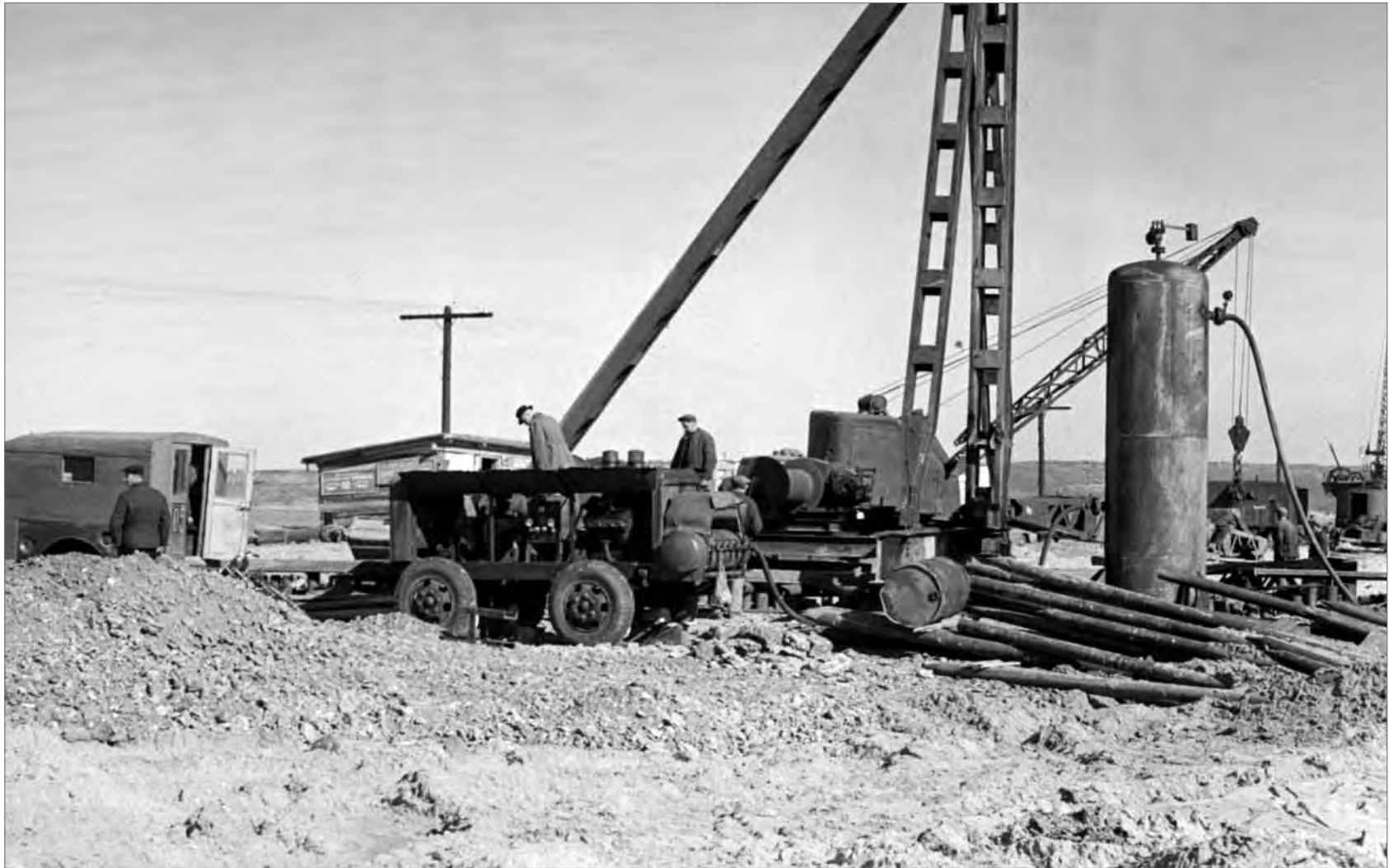
■ Роботи на вхідному каналі та південній шпорі
