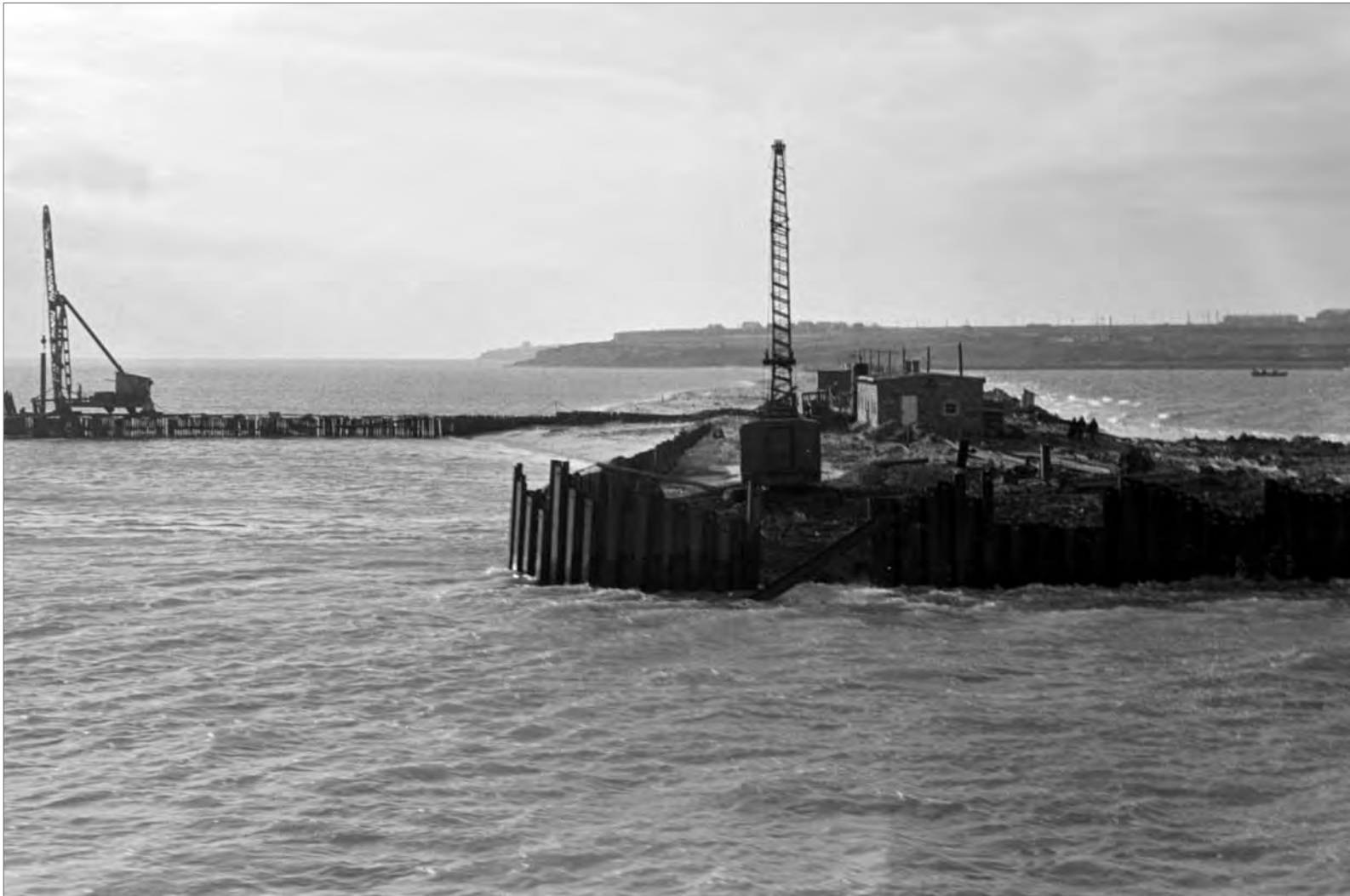
■ Роботи на вхідному каналі
