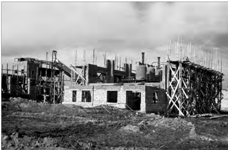
■ Будівництво заводу залізобетонних виробів (1956 р.)
