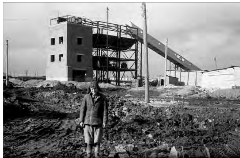
■ Будівництво заводу залізобетонних виробів (1956 р.)
