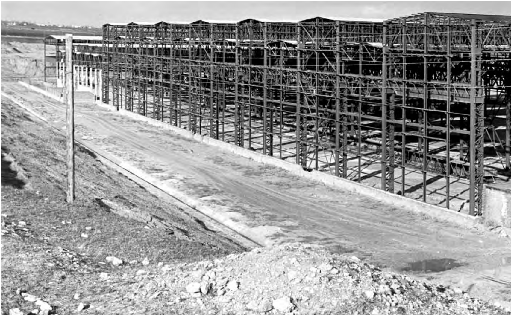
■ Відновлене будівництво БКЦ
