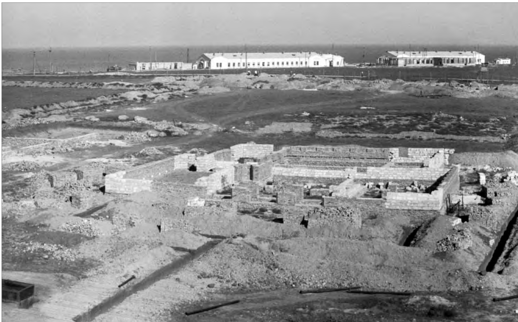
■ Початок будівництва їдальні та інших споруд III-го кварталу (літо 1954 року)
