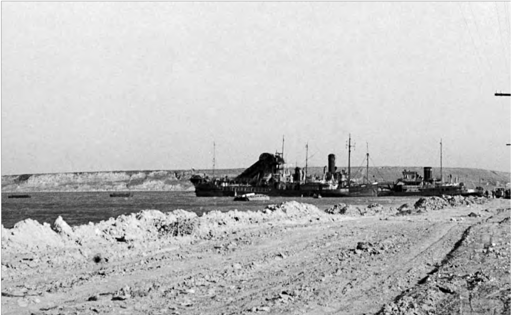
■ Роботи на вхідному каналі
