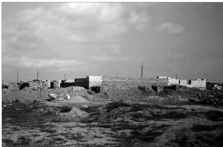
■ Зведення будинків по вул. Будівельній (весна 1954 року)
