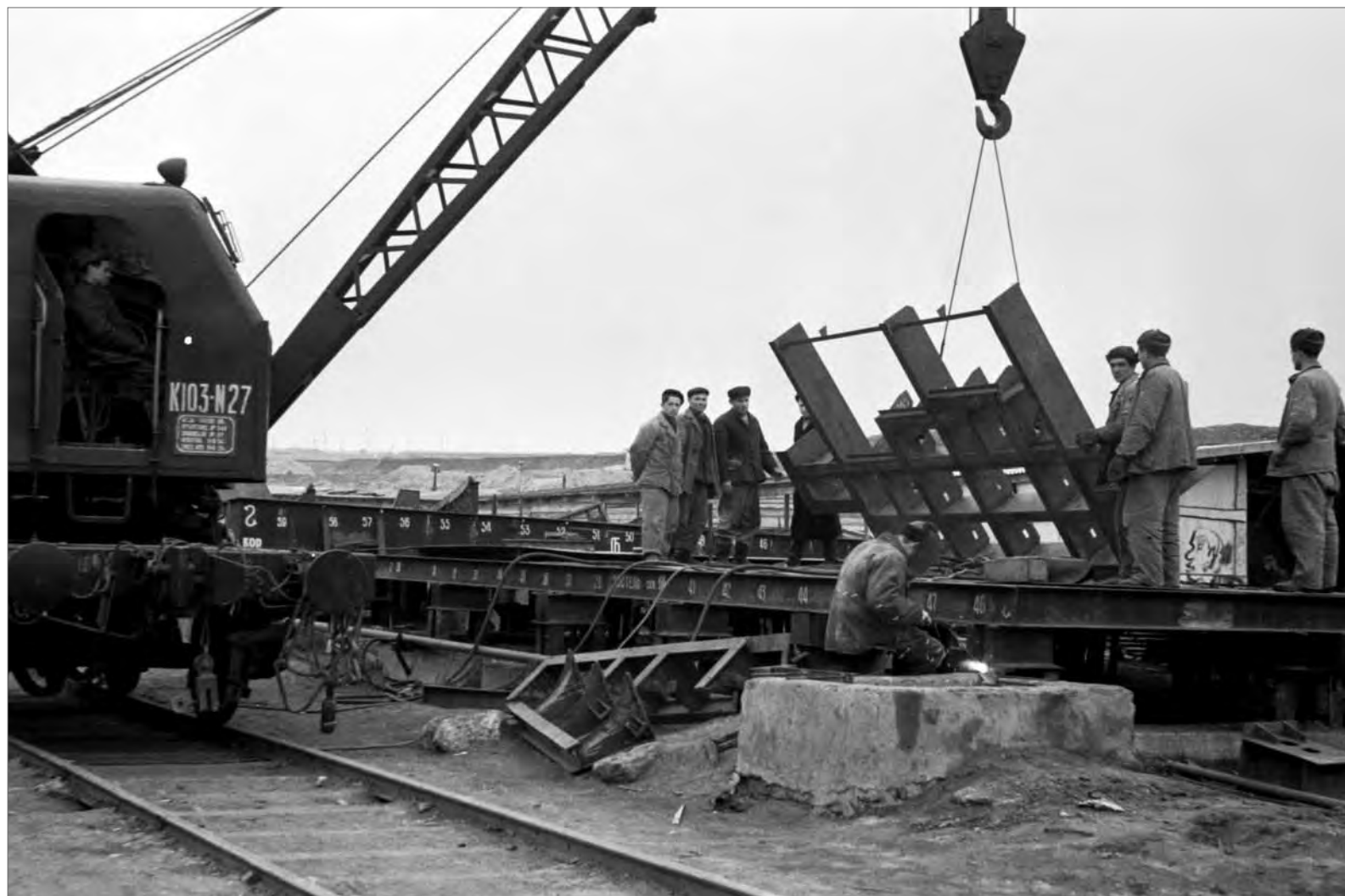
■ Працюють судномонтажники (1956 р.)
