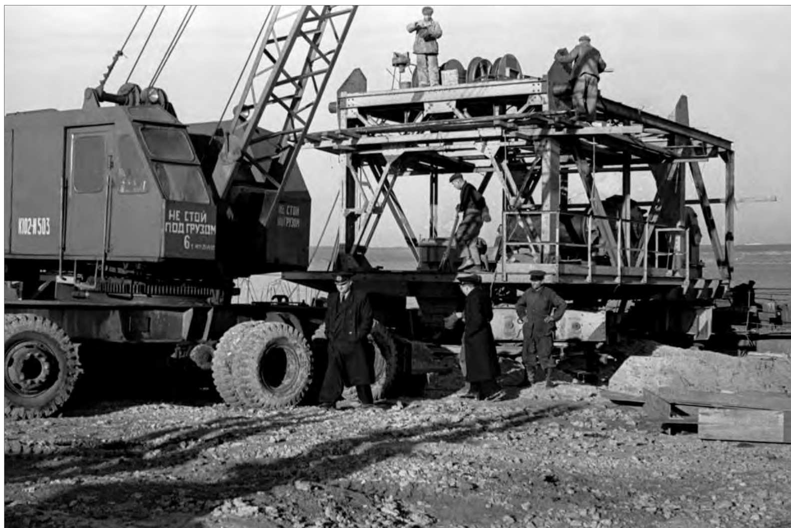
■ Початок монтажу порталного крану
