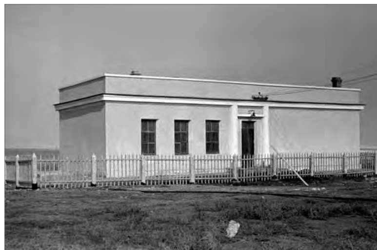
■ Трансформаторна (осінь 1953 року)
