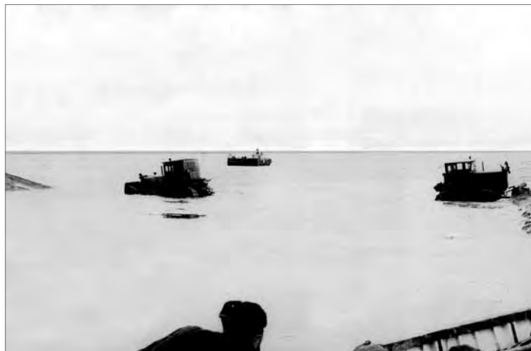
■ Прориття бульдозерами піщаного пересипу (серпень 1953 року)
