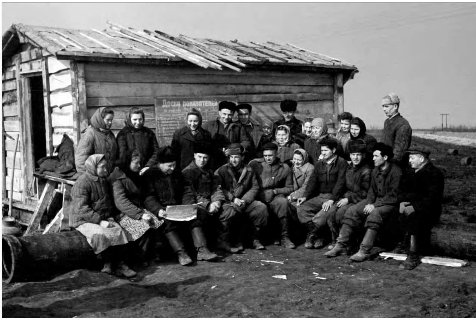
■ Будівництво головного водогону (1955 р.)
