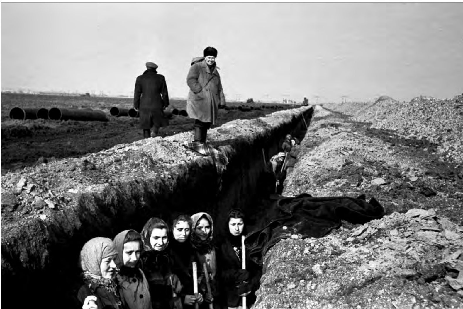
■ Будівництво головного водогону (1955 р.)
