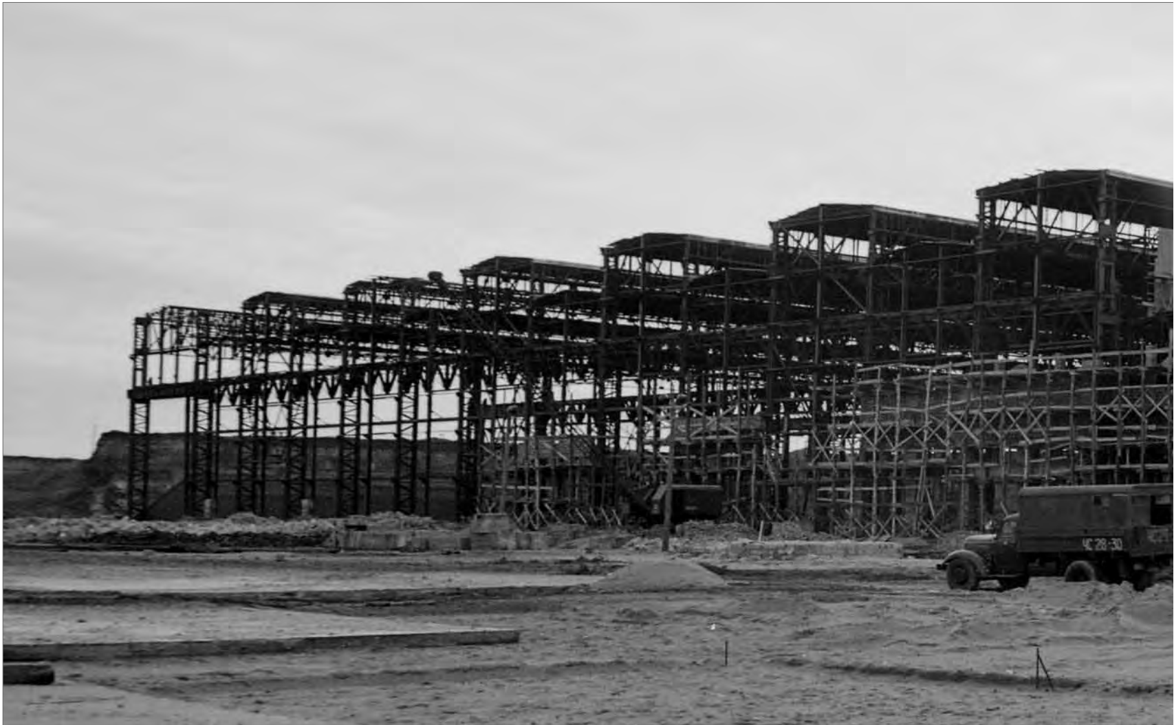
■ Завершення будівництва західної частини БКЦ
