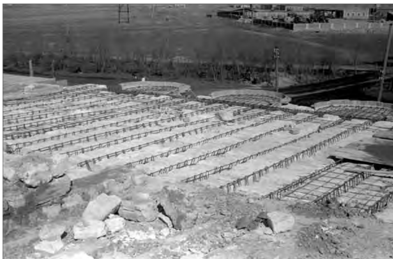
■ Монтаж перекриття на будинку площа Праці 11 (1953 р.)
