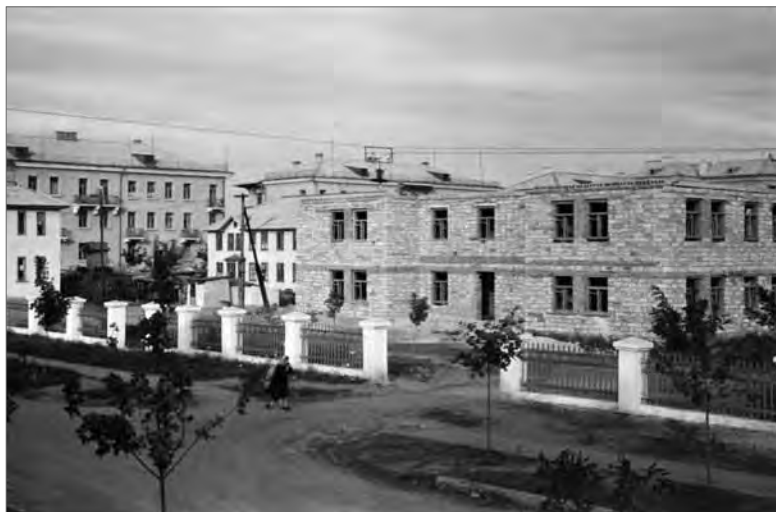
■ Реконструкція будівлі дитячого садка на вул. Шкільній (літо 1957 року)
