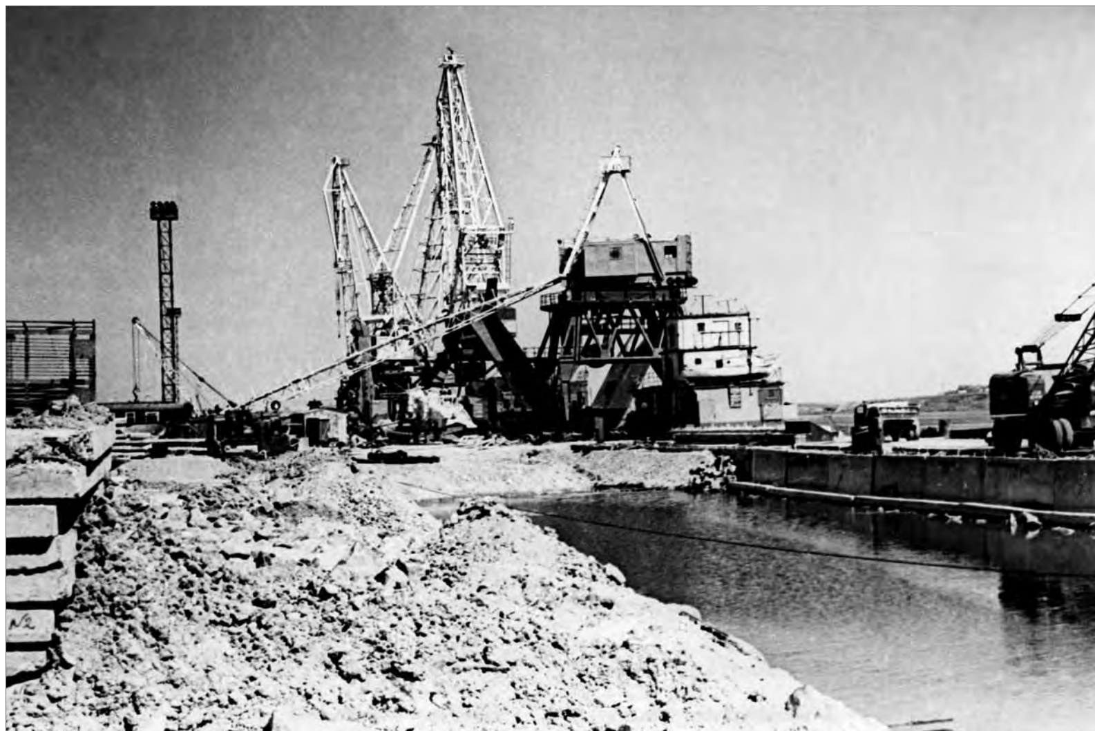
■ Монтаж порталних кранів
