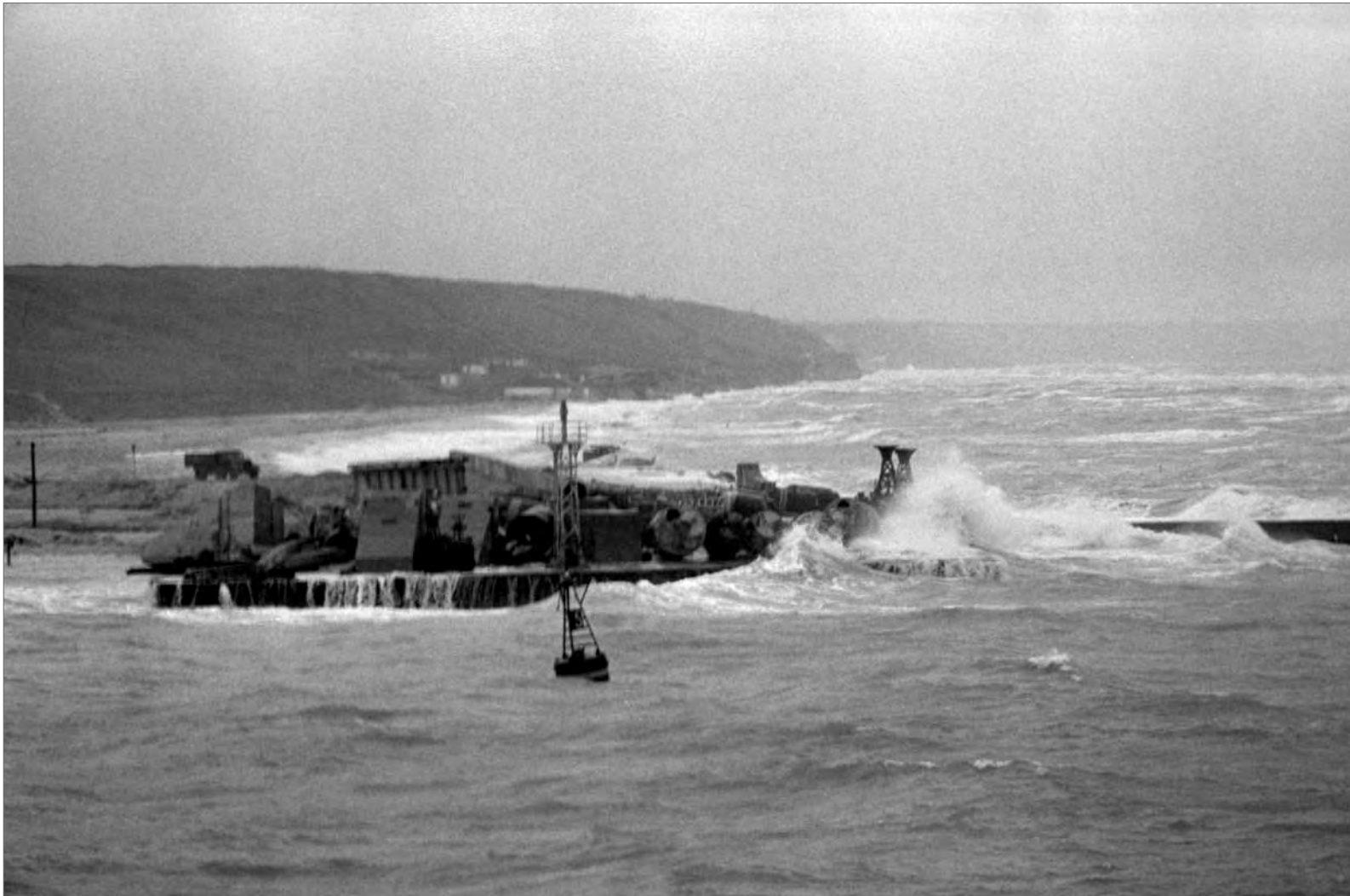
■ Шторм на вхідному каналі (1963 р.)
