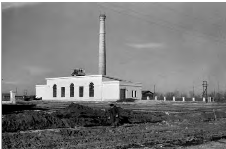
■ Перша котельня (поч. 1953 року)
