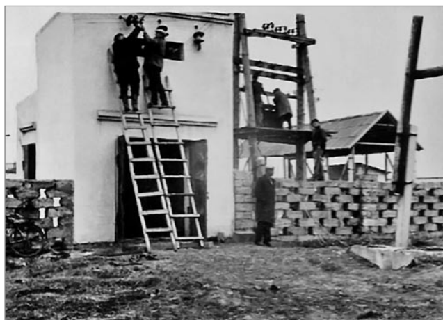
Співробітники РЕМ закінчують будівництво підстанції
