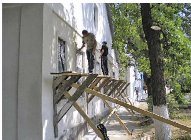
Під час проведення капітального ремонту Великодальницької дільничної лікарні у 2007 році
