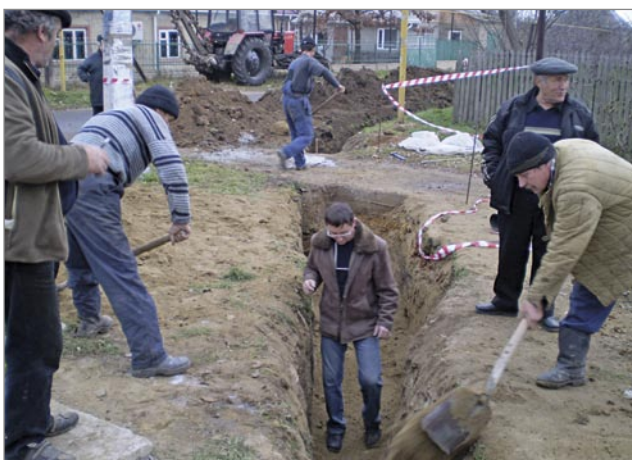
Керівник ВУЖКГ Ю. М. Вовпиловський перевіряє якість виконання робіт під час проведення реконструкції водогону
