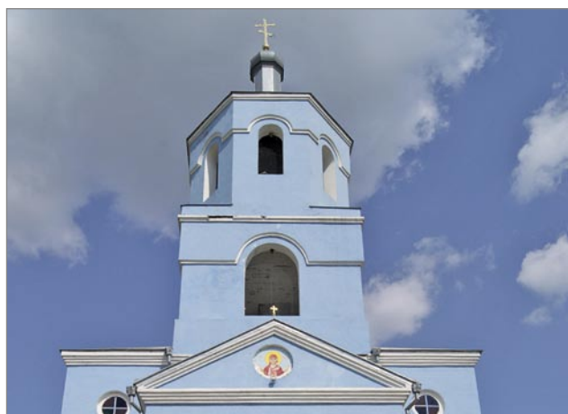
Свято-Покровський храм, будівництво якого завершено у 1995 році
