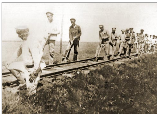
Майстер Лобаньов з бригадою на будівництві вузькоколійки
