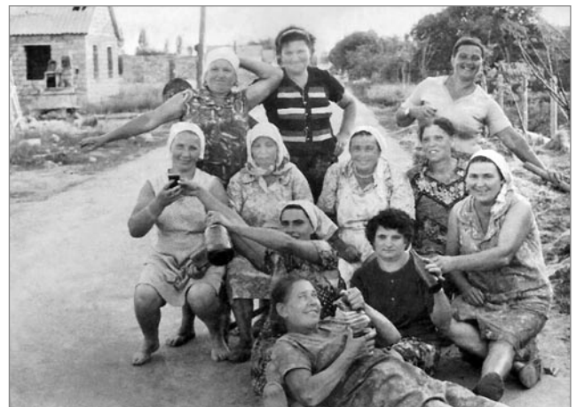
Під час будівництва вулиці Новоселів в Петрівському
