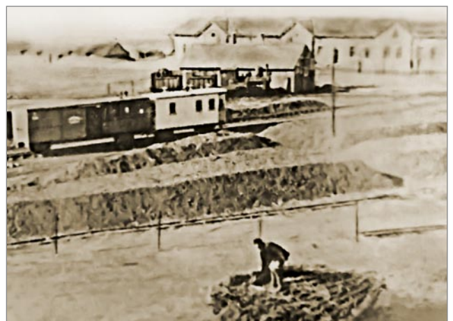
Паливний склад на залізничній станції Вигода
