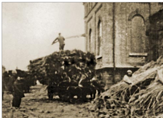
Доставка очерету до котельної
