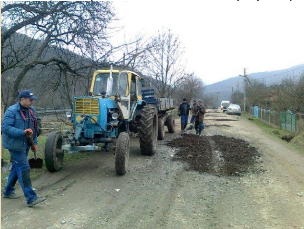
Ремонт вулиці Яблуново
