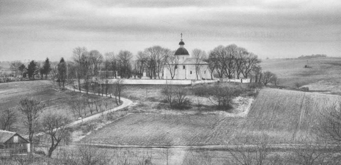
Фото 4. Успенська церква в Дорогобужі. Вигляд зі сходу.
