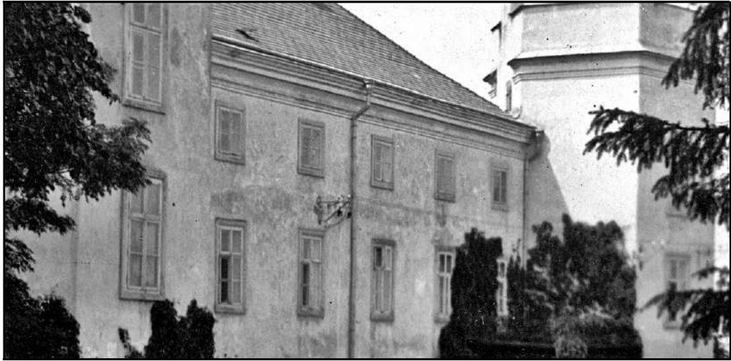
Видно як будинок переходить у башту.
