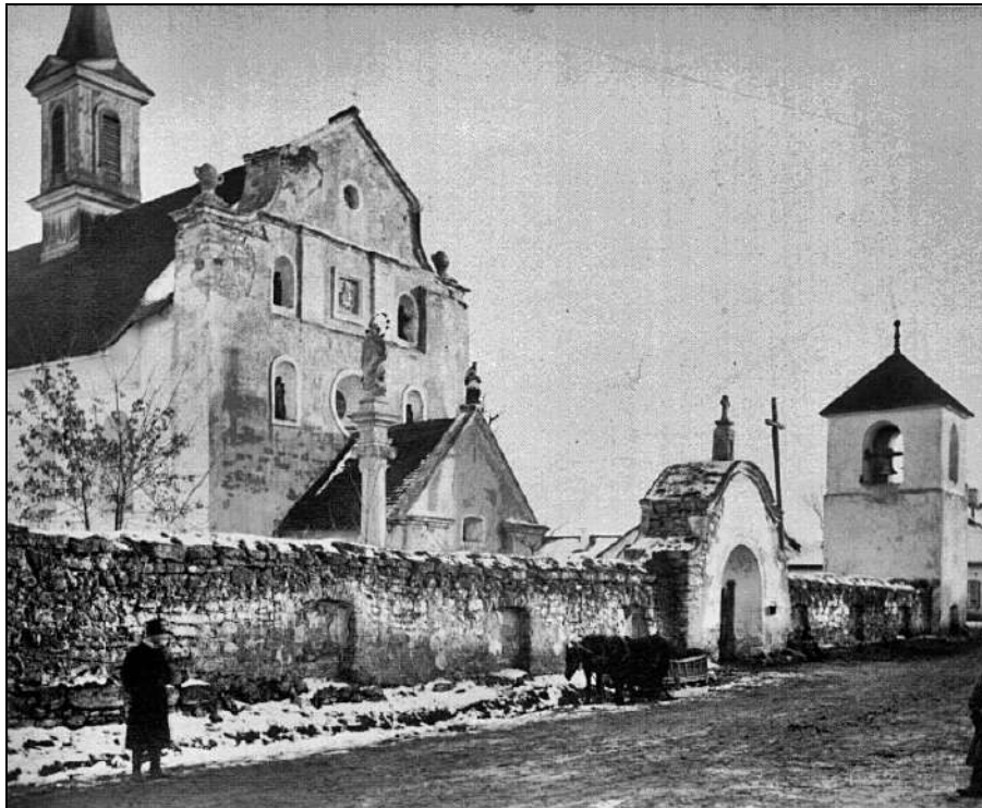
Костьол перед ремонтом у кінці XIX ст.
