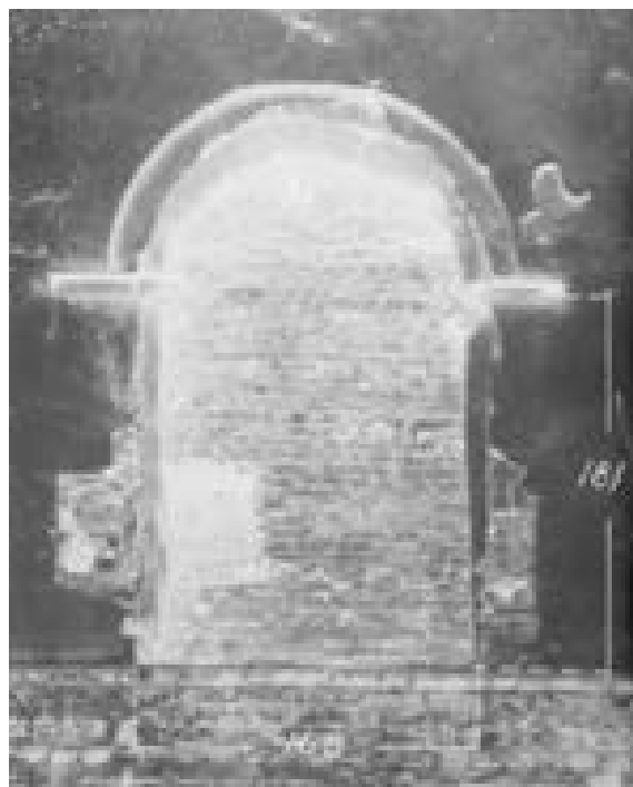
Рис. 7. Софія Київська. Фрагмент I ярусу південного фасаду південно-західної вежі. Фото І.В. Моргілевського 1939 р.
