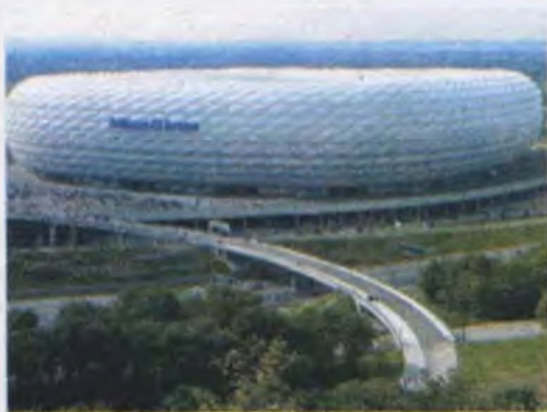
Алліану-Арена. м. Мюнхен (Баварія)
