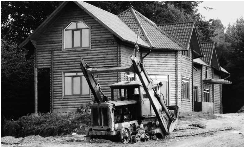
Abb. 10: Moderne Touristenunterkünfte eines kleinen Skigebietes am Nimčyč-Pass bei Vyžnycja im Černivec'ka Oblast'. Allerdings gestaltet sich hier die Zufahrt durch die nur schlecht instand gehaltene Straße besonders im Winter als äußerst schwierig und kann nur mit Spezialfahrzeugen gewährleistet werden. C. Geitner, Sep. 2005.
