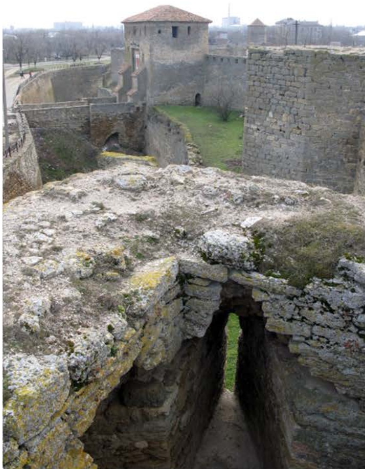
Рис. 12. Вежа № 3 фортеці Білгород. Бійниця під тарасницю південного фланку (фото автора).
