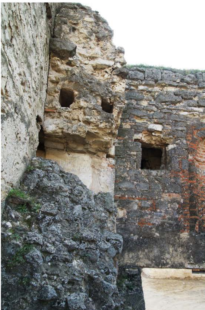
Рис. 7. Фортеця Бендери. Надбрамна вежа (№ 1). Стикувальний шов двох будівельних періодів: 1538 р. і 1584 р. (фото: Д. А. Топал, 2008 р.).
