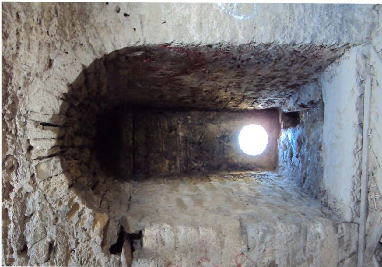
Рис. 22. Вежа № 20. Бійниця від бомбарди в західному фланку.
