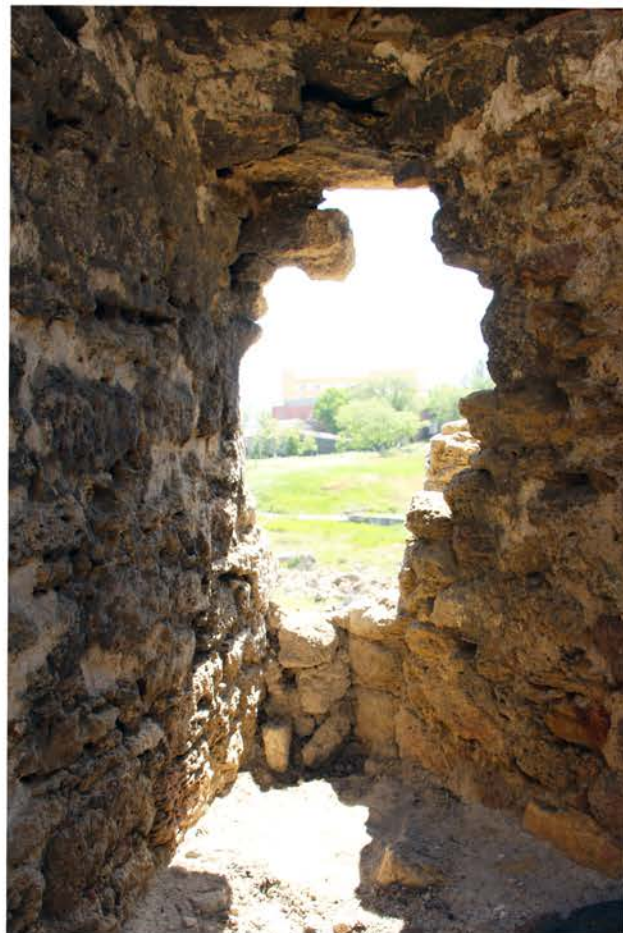
Рис. 13. Вежа № 3. Бійниця під тарасницю східного фланку (фото автора).
