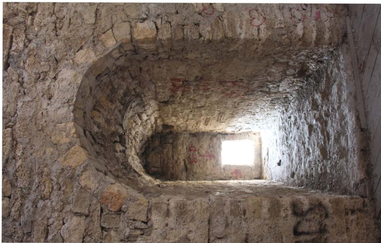
Рис. 21. Вежа № 20 Бійниця від бомбарди в південному фланку.
