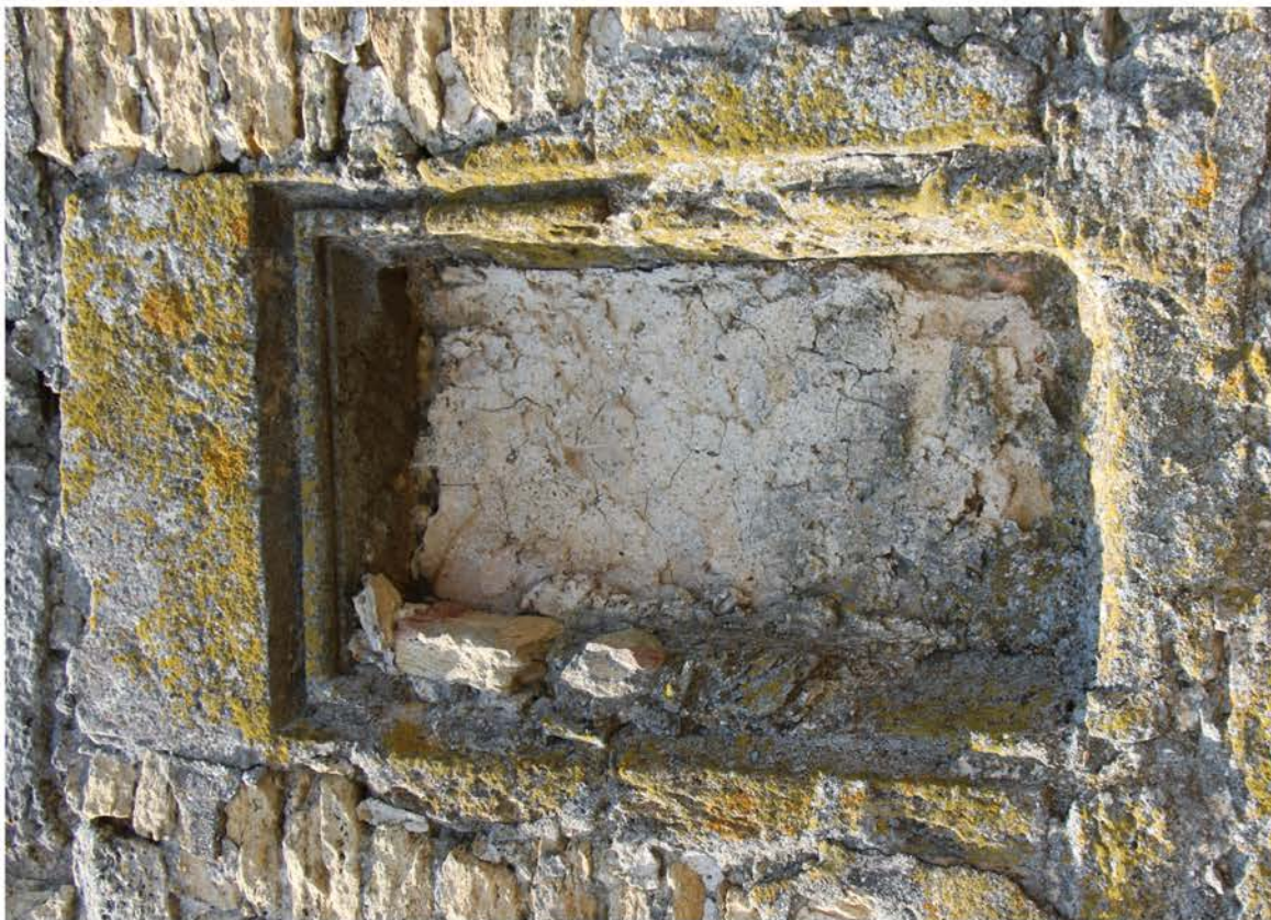
Рис. 18. Ніша будівельної плити 1484 р. Вежа № 6 (фото автора, 2016 р.).
