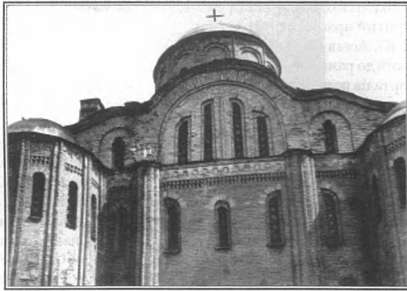
Рис. 17. Фрагмент західного фасаду храму
