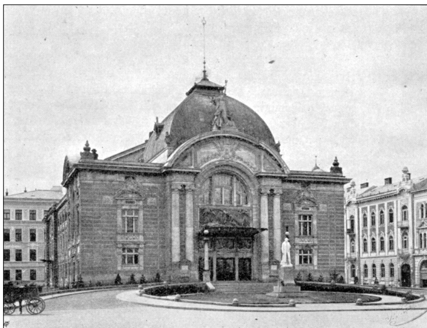
Abb. 82. Neues Theater mit dem Schillerdenkmal.
