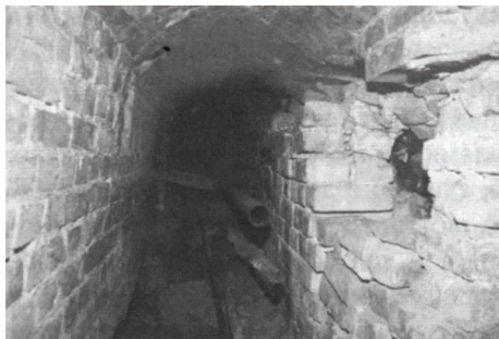
Канали опалювальної системи Успенського собору. Сучасний вигляд
