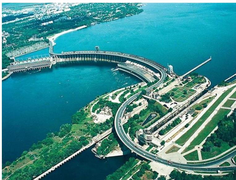
Дніпровська гідроелектростанція – «Дніпрогес», п'ятий ступінь каскаду гідроелектростанцій на річці Дніпро
