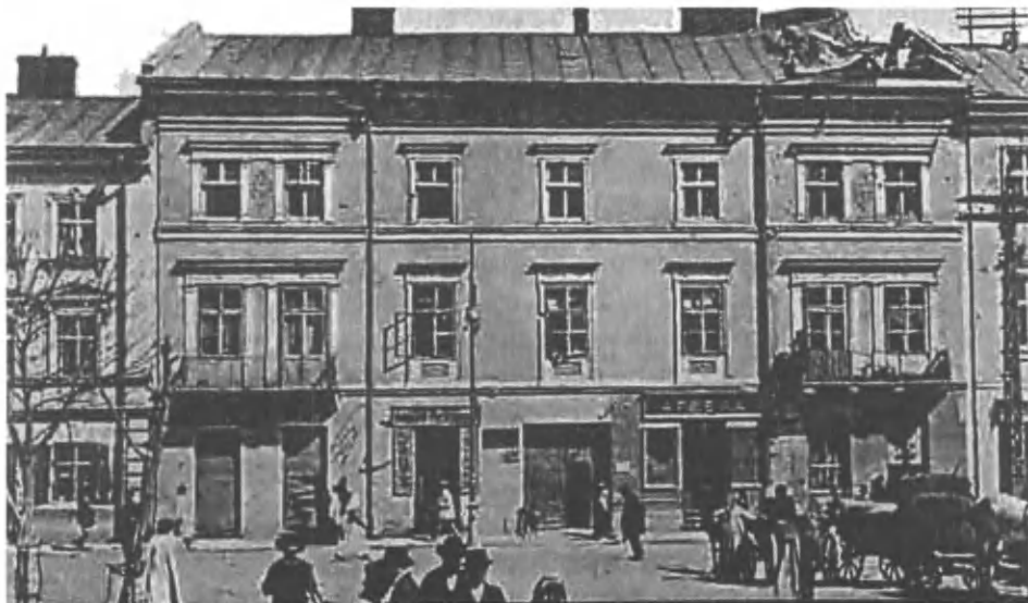
Колишня вулиця Руська. Тепер на цьому місці – будинок побуту “Роксолана”.
