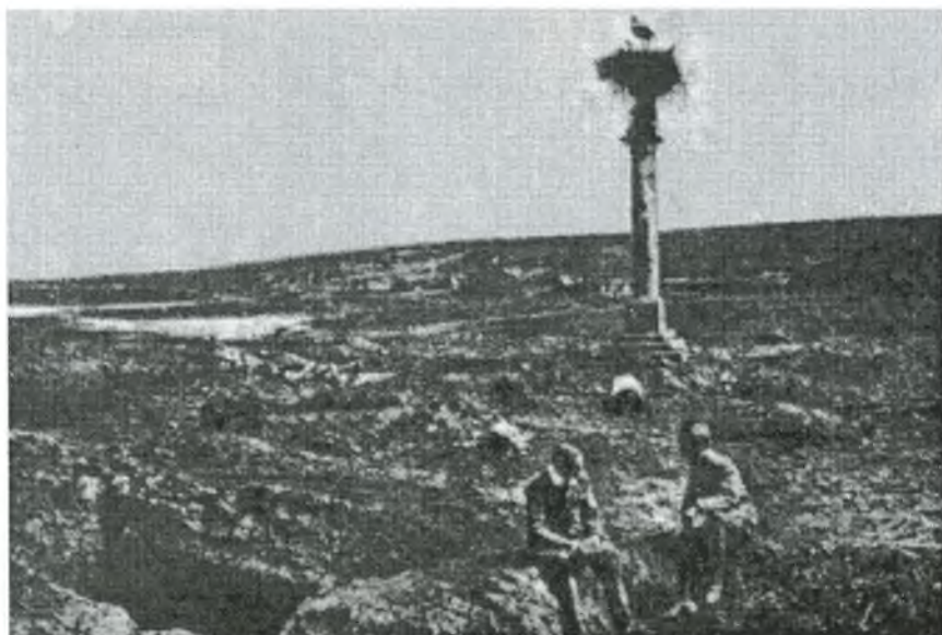
На місці с. Семиківці навесні 1916 р. залишилась одна колона від зруйнованого храму, на якій бузько звив гніздо
