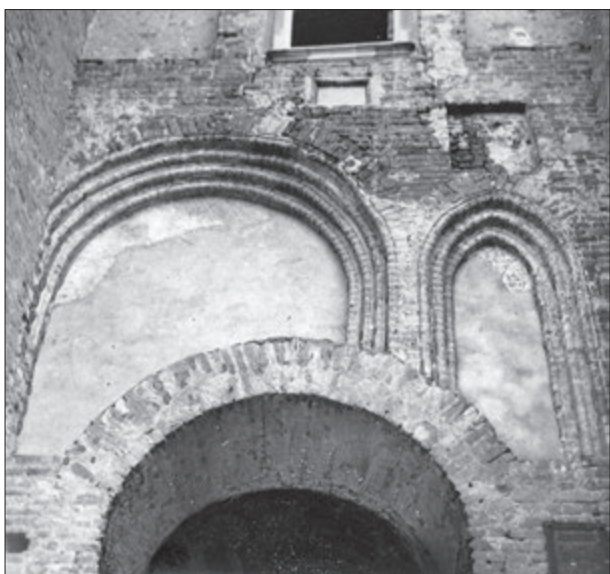
Рис. 5. Луцьк. Верхній замок. Профільоване оформлення ніш на головному фасаді В'їзної башти. Фото О. Годованюк, 1980-і рр.
