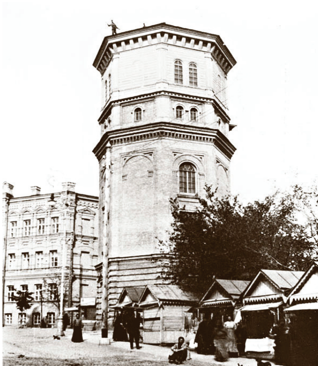
Мал. 5. Михайлівська водонапірна башта, споруджена 1872 р. (інженер Ф. Донат, А. Струве, арх. О. Шілле)
