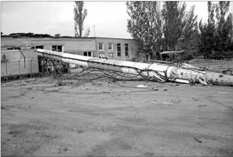
Підірвана труба котельної, червень 2014 р.
