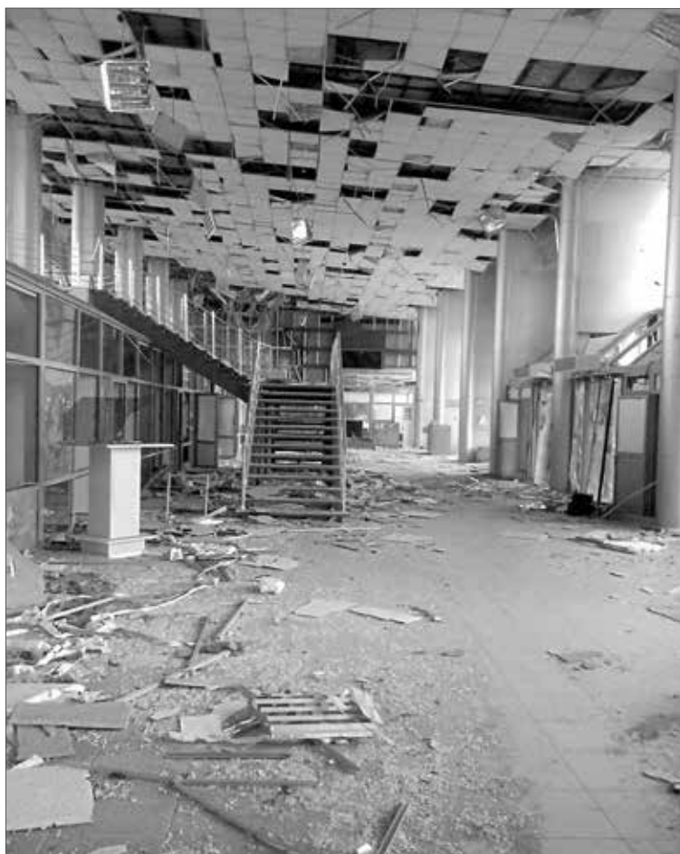
Будівля аеровокзалу всередині станом на 13 серпня 2014 р.
