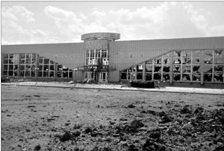
Будівля аеровокзалу станом на 6 серпня 2014 р.
