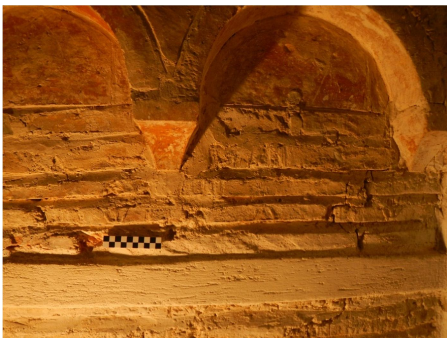
13.13. Аркатурний пояс та мурування апсиди капели першого ярусу. Фото Р.М. Луценка, 2016 р.
