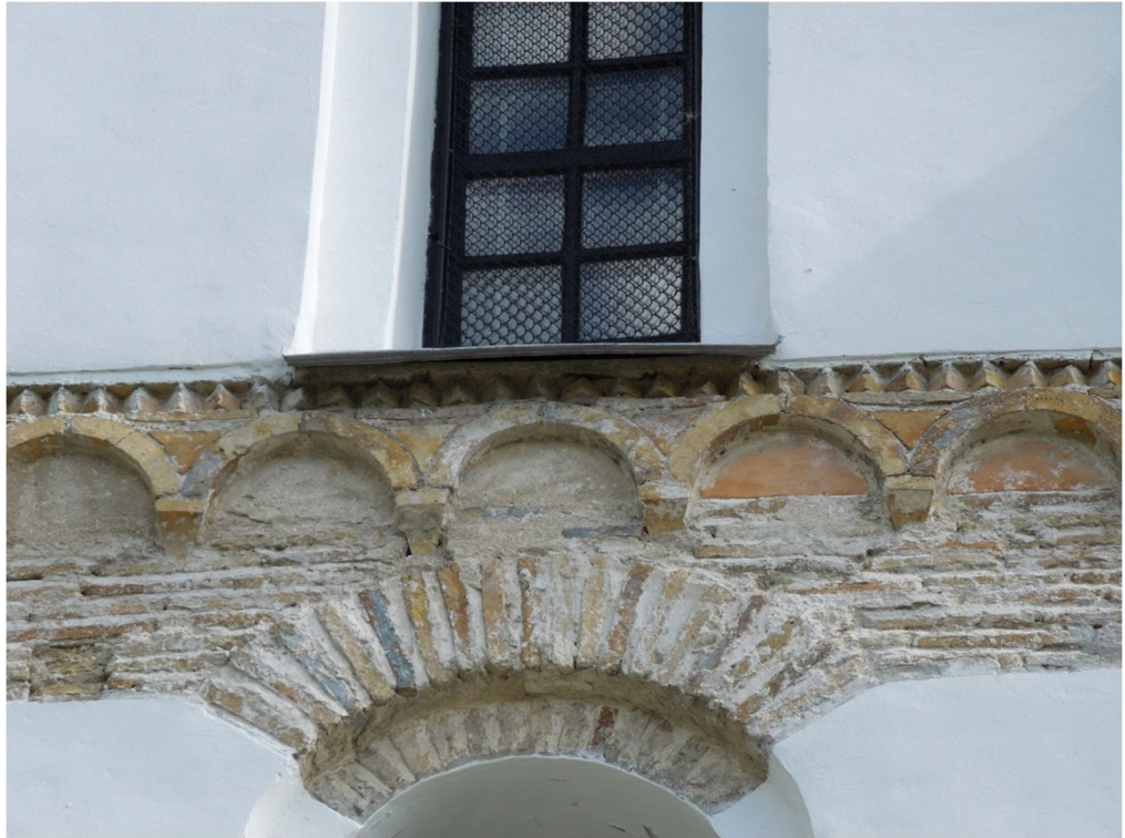
13.9. Аркатурний пояс на західному фасаді. Демонстраційний зондаж. Фото А.О. Логинової, 2016 р.
