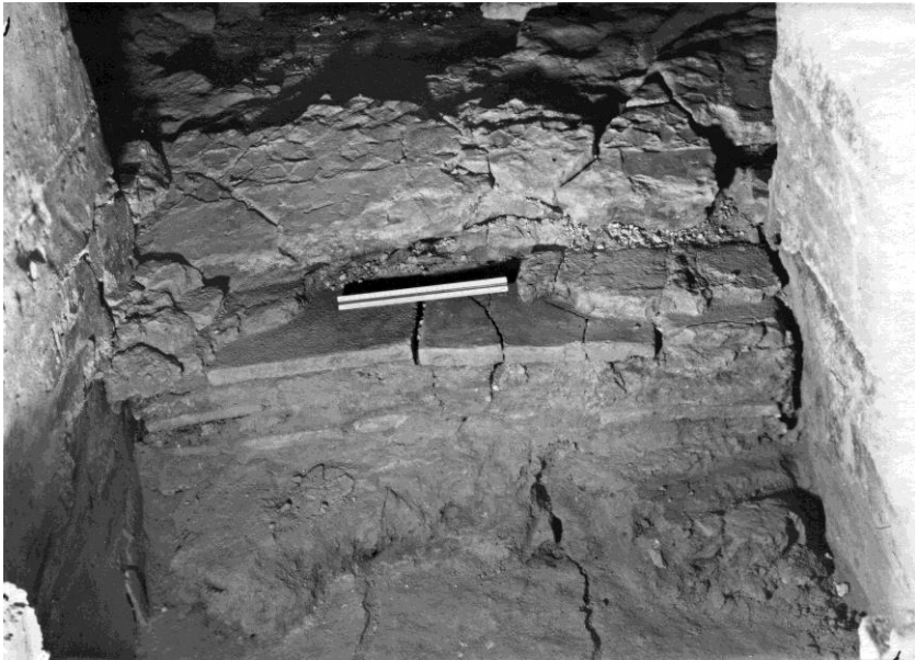
Мал. 129. Прокладання повітропроводу у віттарній частині Софійського собору. Січень 1953 р. Деформована давня підлога, перемичка з плінфи на давньому розчині та примикання фрескового тиньку до давньої підлоги. Вигляд з приділа св. Йоакима та Анни після видалення шиферної плити та давнього ремонту підлоги (НАДР, 916, арк. 15)
