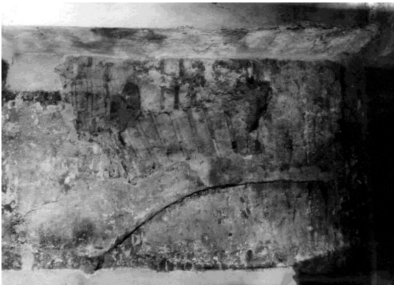
Мал. 136. Прокладання повітропроводу у віттарній частині Софійського собору. Січень 1953 р. Стрічковий фундамент під проймою між приділом Петра і Павла та Георгіївським приділом (друга пройма від центральної нави на північ). Шиферна плита видалена. На фото: стрічковий фундамент заходить під східний стовп, верхня частина фундаменту зруйнована, під стовпом помітний шар розчину, покладений поверх мурування (насухо) фундаменту (НАДР, 917, арк. 13)
