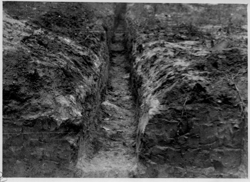
Мал. 8. Роботи з прокладання траншеї ТЕЦ, перше коліно. Вигляд з боку Софійського собору. 1945 р. (НАДР, 923, арк. 33)
