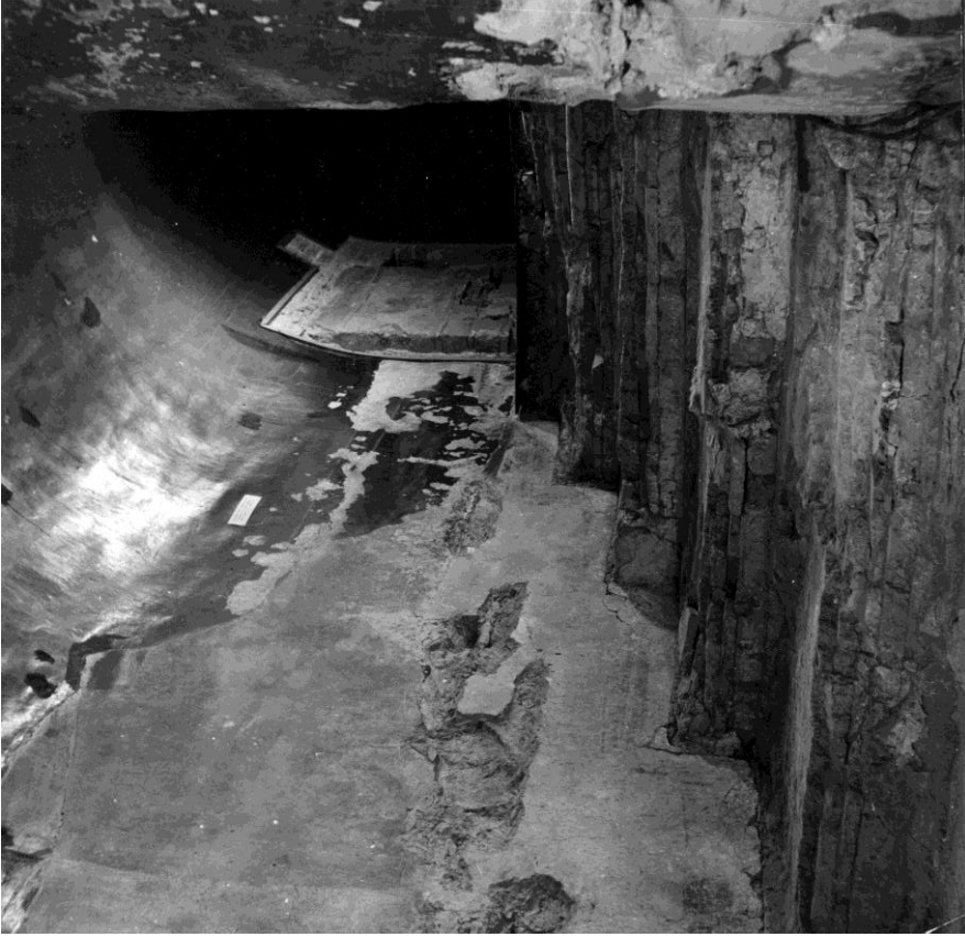
Мал. 200. Нижня частина сходового маршу середини XIX ст. після демонтажу чавунних сходинок (НАДР, 91/2, арк. 15)
