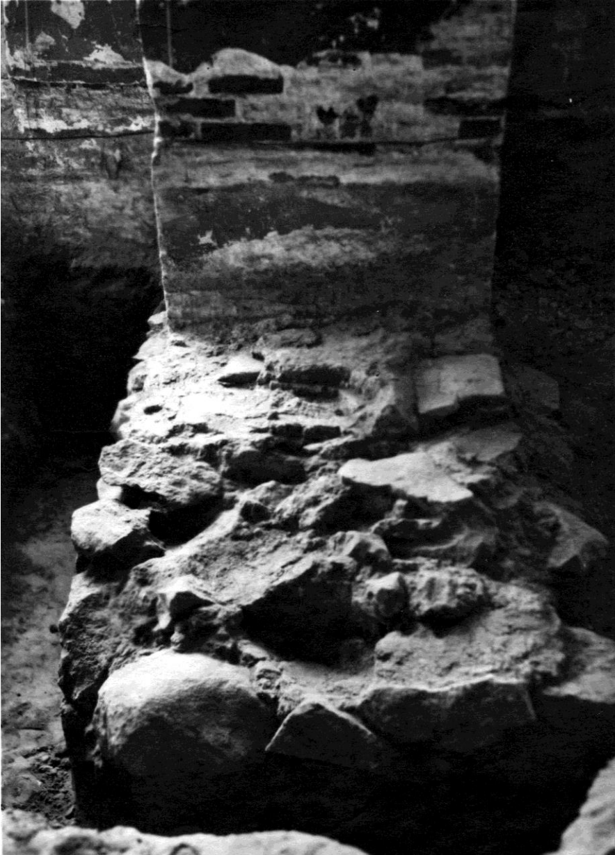
Мал. 69. П'ята аркбутану у південній зовнішній галереї. Серпень 1949 р. Розкоп № 8 (Н, 1604)
