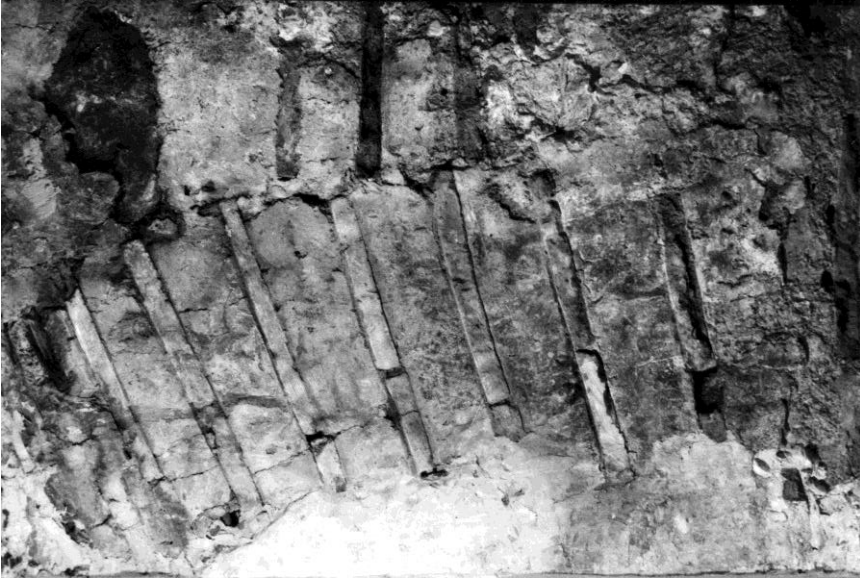
Мал. 138. Фрагмент аркбутану біля північної стіни вежі (т/з, с/р)
