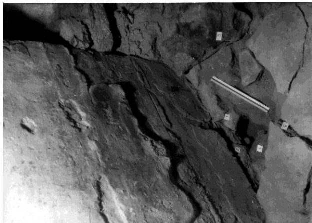
Мал. 134. Прокладання повітропроводу у вітарній частині Софійського собору. Січень 1953 р. Дослідження стрічкового фундаменту. Частина шару розчину, що розтріскався (2) піднята (5), відкрите бутове мурування насухо (1, 4) фундаменту. Між каменями (1–4) пуста. Шар розчину (3) заходить під стіну (західний бік пройми, що з'єднує приділ Йоакима та Анни із головним вітарем (НАДР, 917, арк. 12)
