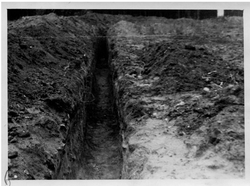
Мал. 7. Роботи з прокладання траншеї ТЕЦ, перше коліно. Вигляд з боку Софійського собору. 1945 р. (НАДР, 923, арк. 32)
