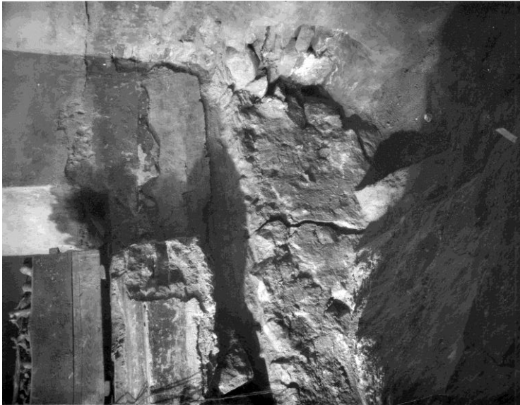
Мал. 170. Східна частина північної зовнішньої галереї (А-3). Жовтень 1955 р. Фундамент під східною стіною А-3 та його примикання до фундаменту під південною стіною. На східній стіні збереглась фреска. У точці “А” дослідковано кут давнього відкосу (т/з, s/p)
