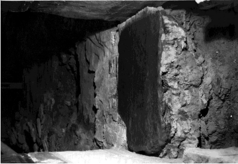
Мал. 126. Прокладання повітропроводу у вітарній частині Софійського собору. Грудень 1952 р. Шиферна плита та сліди ремонту давньої підлоги керамічними плитами. Вигляд з приділа свв. Йоакима та Анни (НАДР, 917, арк. 8)
