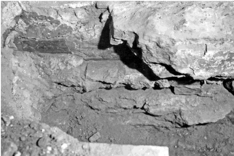
Мал. 151. Східна частина північної зовнішньої галереї. Грудень 1954 р. Стіна, що розділяє членування А-2 та А-3. Фрагмент західної поверхні біля залишків північної пілястри XVIII ст. Під цегляним муруванням пілястри лежить камінь на вапняково-піщаному розчині. Ще нижче на відмітці –80 зберігся розчин з цем'янкою – верх давнього стрічкового фундаменту. Ліворуч пілястри збереглась давня стіна, покрита фрескою з граф'єю. Фреска збереглась від –73 до –30. На фото помітні залишки двох давніх підлог: на відмітці –62 плінфа на глинистому розчині, і на відмітці –71 – розчин з цем'янкою, покладений на шар будівельного сміття, залитий білим розчином із зернами цем'янки (НАДР, 917, арк. 53)
