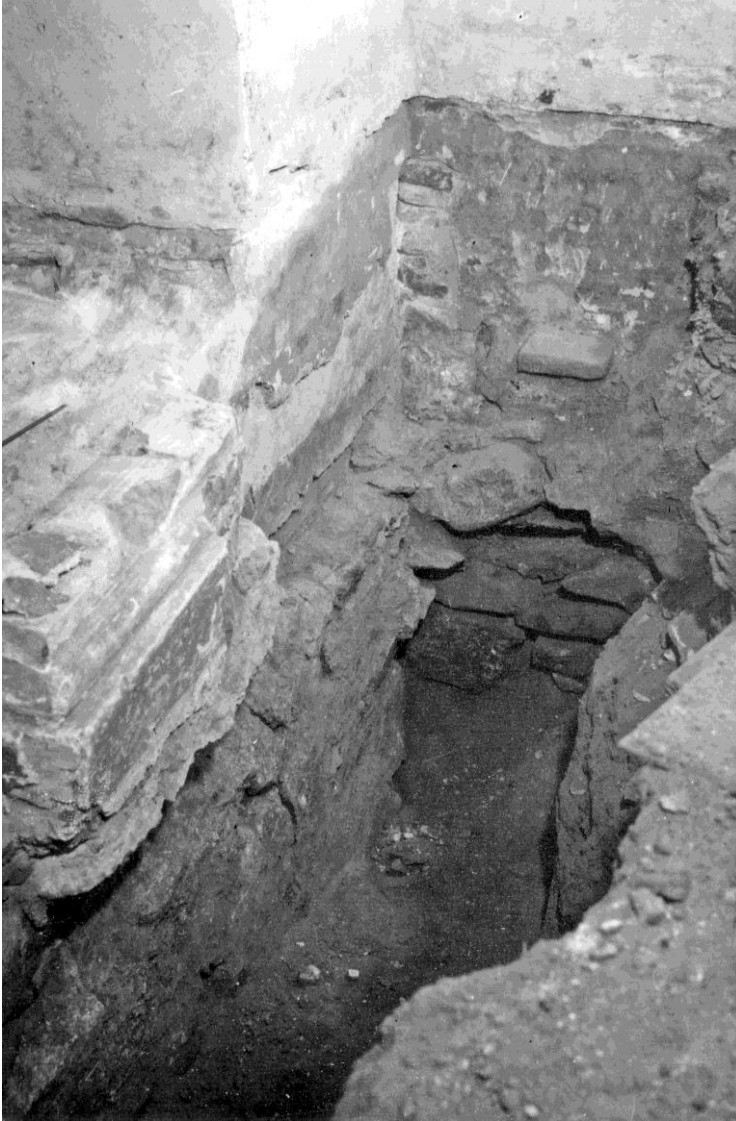
Мал. 152. Друге зі сходу членування першого поверху північної зовнішньої галереї (А-3). Грудень 1954 р. Зондаж у південно-східному куті. Фундамент південної стіни з буту насухо. Підосва на глибині 171 см; над урізом (-78) збереглись залишки розчину давньої підлоги (-73); вище на глибині збереглась цегла підлоги XVIII ст. Фундамент східної стіни стрічковий з буту на розчині із цем'янкою. Підосва -173; уріз -93; давня підлога -73, підлога XVIII ст. -56. Південна стіна вище -72 складена на вапняково-піщаному розчині, східна стіна у нижній частині давня, вкрита фрескою від рівня давньої підлоги (-73) до відмітки -33 та, вірогідно, йде ще вище під тиньк XVIII ст. На фото помітна також база південної пілястри portalу XVIII ст. (НАДР, 917, арк. 54)
