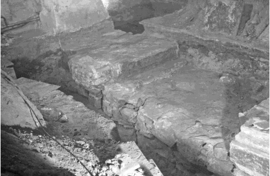
Мал. 149. Східна частина північної зовнішньої галереї. Грудень 1954 р. Північна частина залишків стіни, що розділяла членування А-2 та А-3 на першому поверсі північної зовнішньої галереї. Сфотографовано з південного заходу. На північному відкосі проїми XVIII ст. збереглося пофарбування темно-зеленою фарбою з орнаментом, виконаним білою (світло-зеленою) фарбою. На базі південної пілястри добре зберігся профіль, база північної пілястри збереглась набагато гірше. Плінфа "А" лежить поверх давнього фундаменту на розчині з цем'яною (відмітка верху плінфи -76), вище покладений шар каміння на вапняково-пісковому розчині (НАДР, 916, арк. 34).
