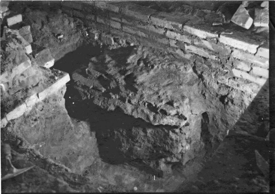
Мал. 139. Західна частина північної зовнішньої галереї. Лютий 1953 р. Розкритий фундамент аркбутану № 2. 1 – місце дерев'яного кілочка (НАДР, 916, арк. 16)
