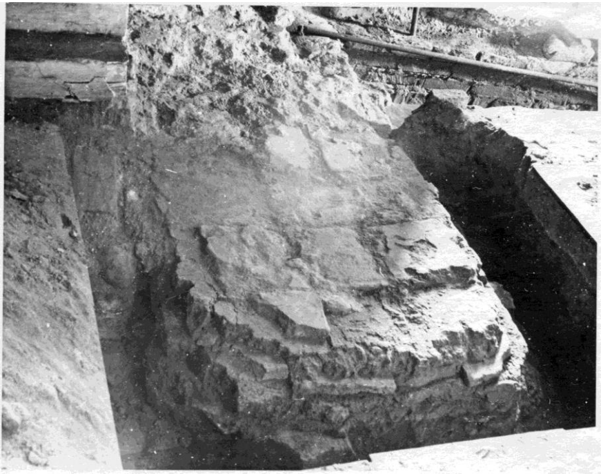
Мал. 145. Софійський собор. Квітень 1953 р. Західна частина південної внутрішньої галереї. Залишки аркбутану біля виходу на схід від цього виходу (II-5, II-6). Розкрита під час прокладання труб водяного опалення (НАДР, 916, арк. 18)
