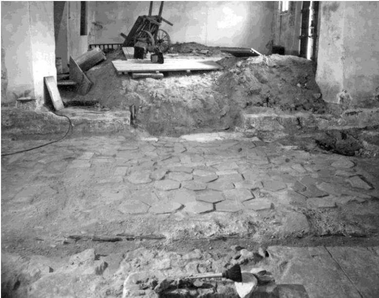
Мал. 154. Східна частина північної зовнішньої галереї (А-2). Серпень 1955 р. Загальний вигляд зі сходу після розкриття підлоги XVIII ст. (відмітка –156). На передньому плані пробита у підлозі штроба із залишками дерев'яного лежня (НАДР, 916, арк. 27)
