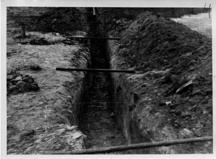
Мал. 10. Роботи з прокладання траншеї ТЕЦ, друге коліно. Вигляд зі сходу. 1945 р. (НАДР, 923, арк. 30)
