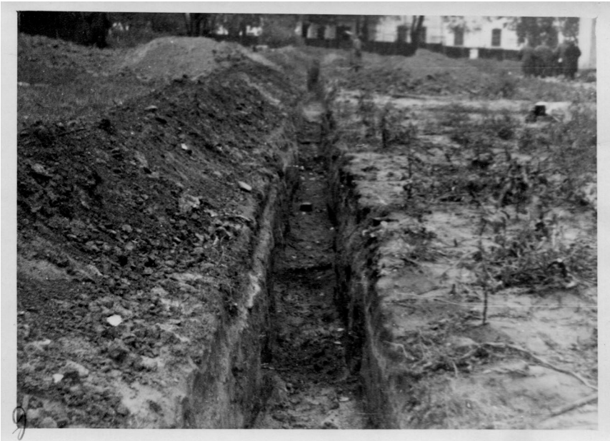
Мал. 9. Роботи з прокладання траншеї ТЕЦ, перше коліно. Вигляд з боку Софійського собору. 1945 р. (НАДР, 923, арк. 35)
