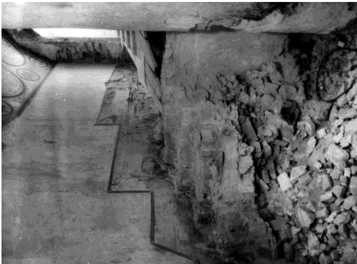
Мал. 200. Нижня частина сходового маршу середини XIX ст. після демонтажу чавунних сходинок (НАДР, 91/2, арк. 15)
