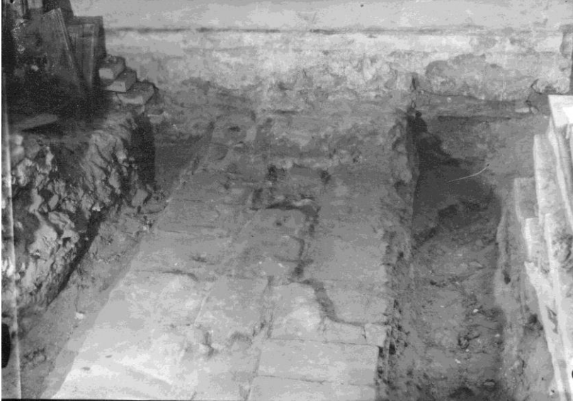
Мал. 142. Західна частина північної зовнішньої галереї. Лютий 1953 р. Примикання до північної стіни галереї аркбутану № 4. В кутках збереглася давня підлога та залишки фрескового тиньку (НАДР, 916, арк. 17)
