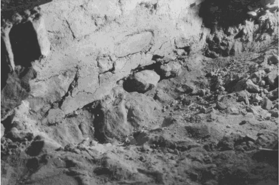
Мал. 136. Прокладання повітропроводу у віттарній частині Софійського собору. Січень 1953 р. Стрічковий фундамент під проймою між приділом Петра і Павла та Георгіївським приділом (друга пройма від центральної нави на північ). Шиферна плита видалена. На фото: стрічковий фундамент заходить під східний стовп, верхня частина фундаменту зруйнована, під стовпом помітний шар розчину, покладений поверх мурування (насухо) фундаменту (НАДР, 917, арк. 13)
