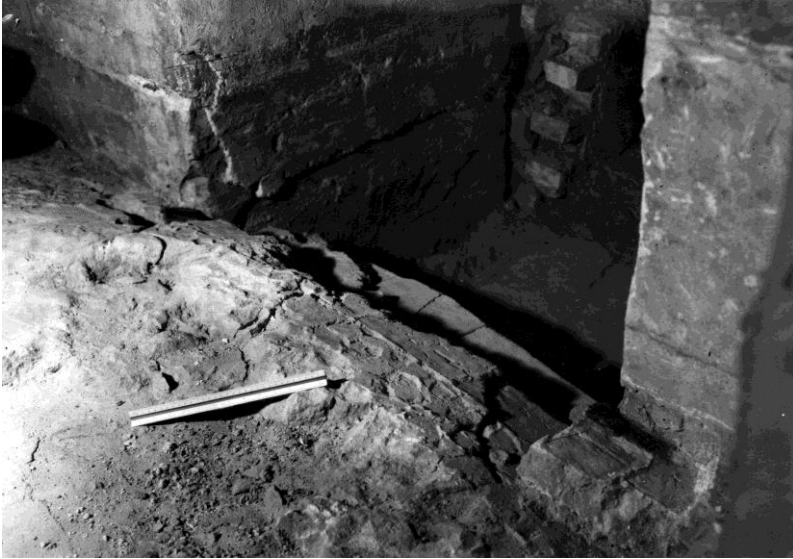
Мал. 130. Прокладання повітропроводу у вітарній частині Софійського собору. Січень 1953 р. Деформована давня підлога, відкрита після видалення ремонту. Праворуч біля стіни помітні залишки давнього ремонту зі збереженою смальтою. Вигляд з боку головного вітаря (т/з, s/p)
