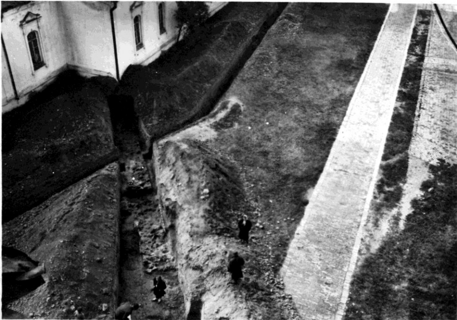
Мал. 40. Розкопки фундаментів огорожі 1948 р. Друга ділянка. Вигляд з дзвіниці (НАДР, 921, арк. 103)
