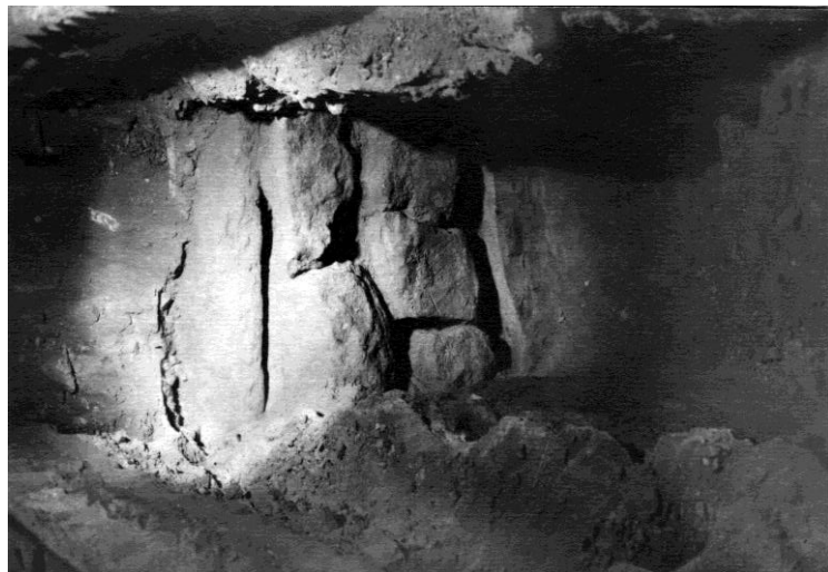
Мал. 135. Прокладання повітропроводу у вітарній частині Софійського собору. Грудень 1952 р. Стрічковий фундамент під проймою приділа свв. Петра і Павла та Георгійським приділом (друга пройма від центральної нави на північ). Під фундаментом лежить шиферна плита. Під фундаментом помітна нерозчищена поверхня нерушеного лесу (т/з, s/p)
