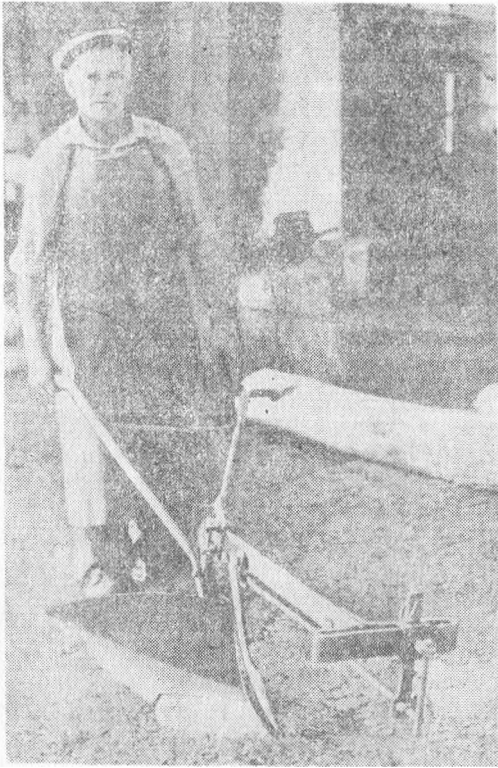
Плуг для садової оранки, виготовлений ковалем М. В. Демчиком.
