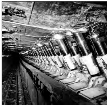
Привибійний (очисний) простір лави.
