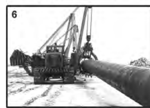
Нафтогазовий комплекс України. Сторінки з історії: 1 – нафтова лампа, 1853 р.; 2, 3 – станки-качалки нафтовидобувних свердловин різних років; 4-6 – прокладення магістральних нафто- та газопроводів.
