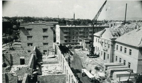
Будівництво житлового масиву по проспекту Леніна в р-ні Рогатки, 1960
