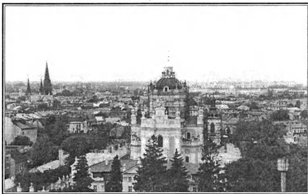
Рис. 74. Комплекс собору св. Юра. Загальний вигляд. Сучасне фото
