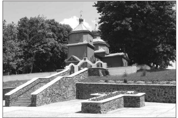
Церква у Нетішині. Сучасне фото.
